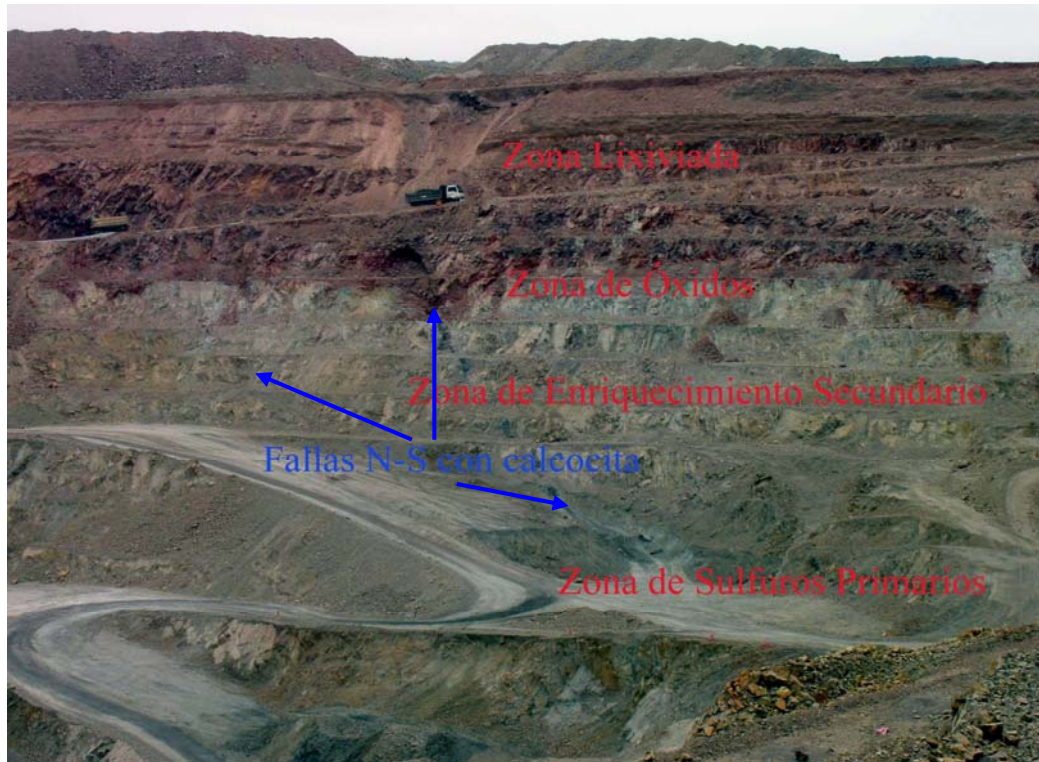
Foto 3. Se observa fallas N10°E/84°S con continuidad a lo largo del rajo Dos Amigos, la falla esta rellena con piritacalcosina en color gris.
