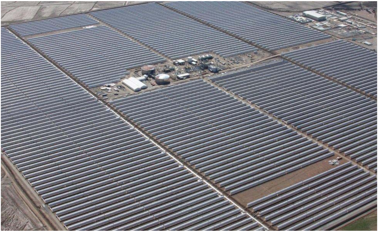
Figura 2.5.2.2, Foto area sistema Andasol, Espana.
