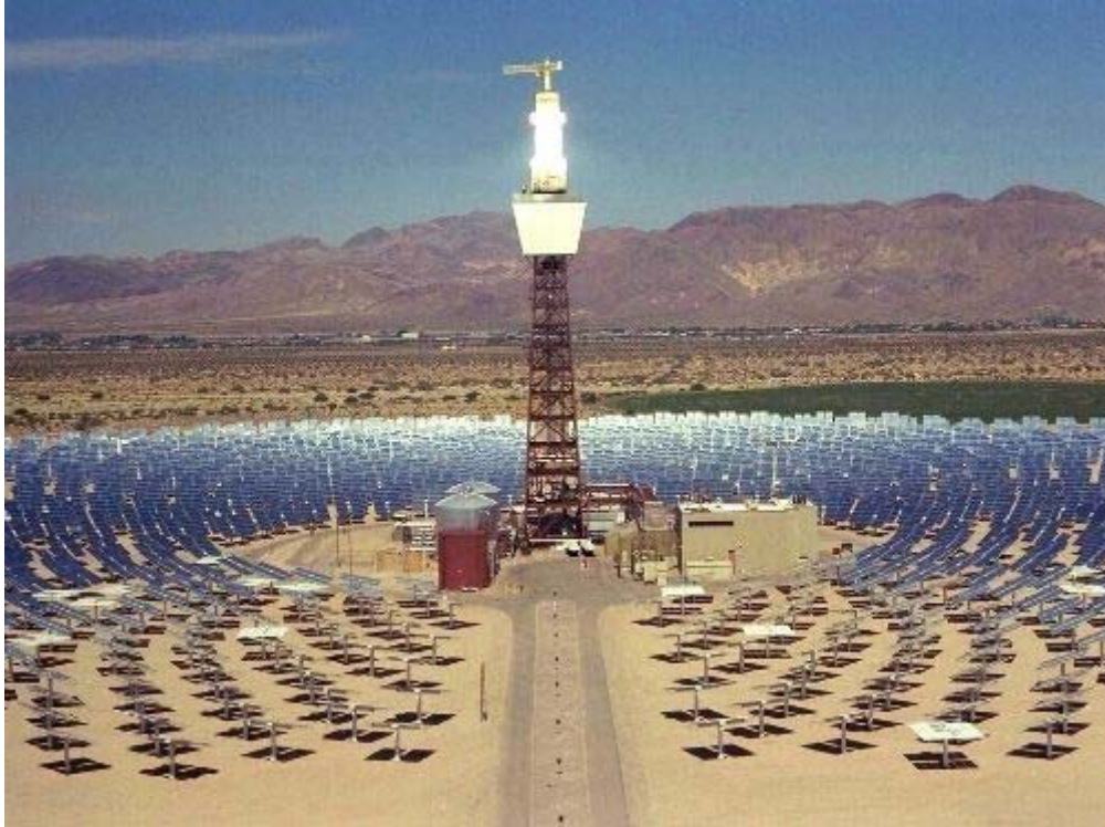
Figura 2.5.1, Torre de Poder
