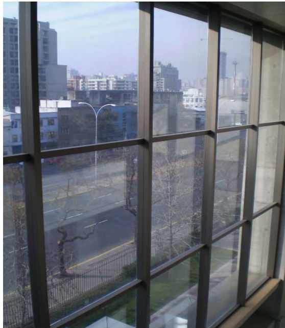
Imagen 13: Fachada norte del edificio en estudio
