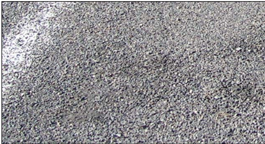
Foto 3.2: Pérdida de Áridos.
