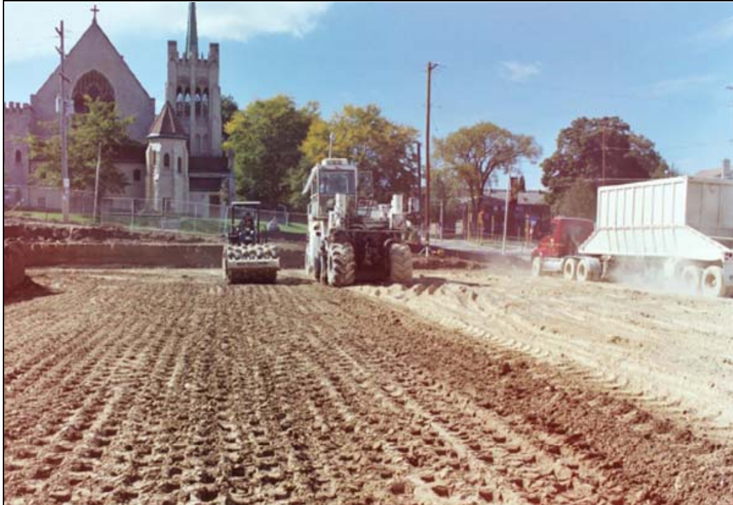
Foto 5.1: fotografía ilustrativa de camino tratado con cenizas volantes.
