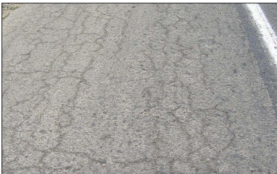
Foto 3.1: Grietas tipo piel de cocodrilo.
