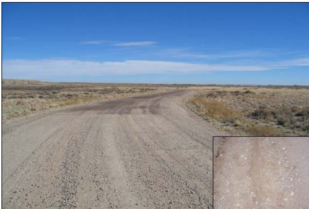
Foto 5.3: fotografía ilustrativa de camino tratado con lignosulfonato.
