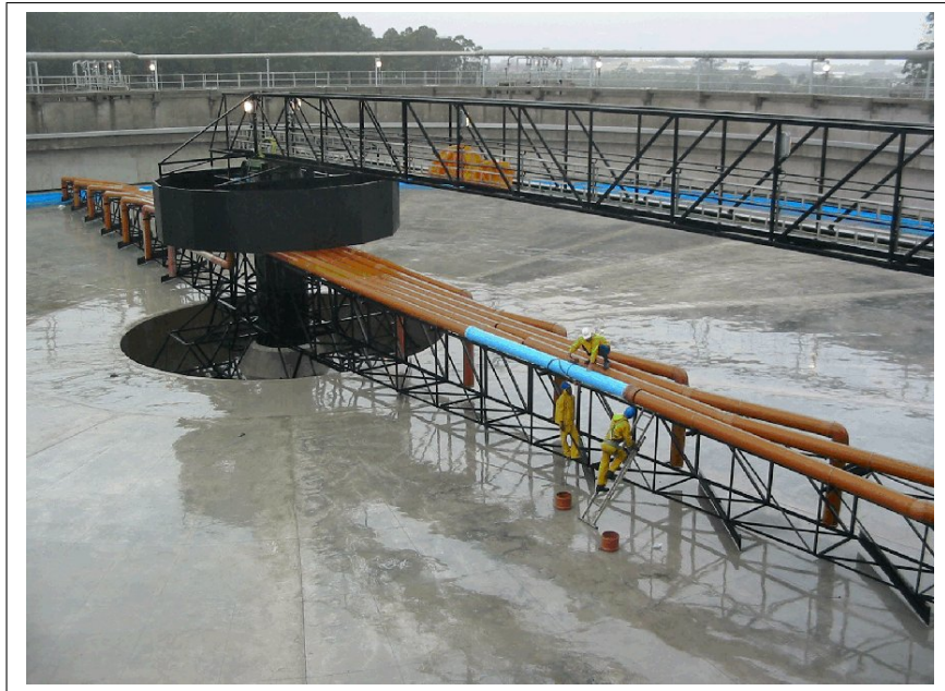
Figura 1.5: Fotografía de clarificador en mantención. En ella se observan las tuberías de las rastras que succionan parte de la recirculación
