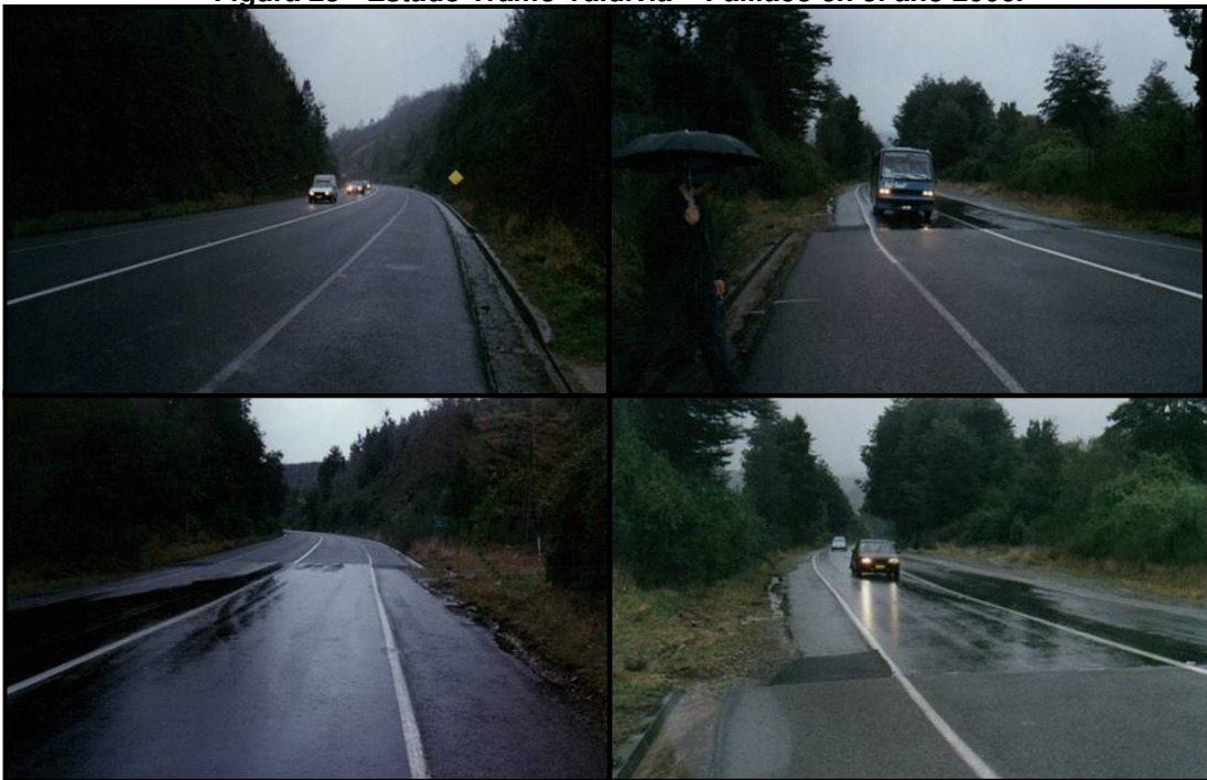
Figura 28 - Estado Tramo Valdivia – Paillaco en el año 2006.
