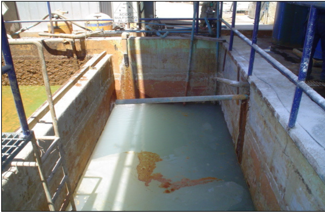
Figura 2-6: Estanque de almacenamiento del RIL
