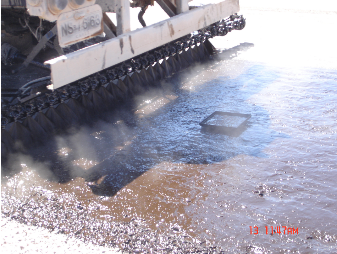
Figura 21: Cálculo de dosificación según peso de la muestra
