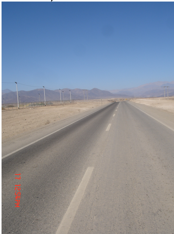
Figura 14: Construcción variante El Jilguero, Km. 0,000 al Km. 6,120 Huasco Región de Atacama (Panorámica)
