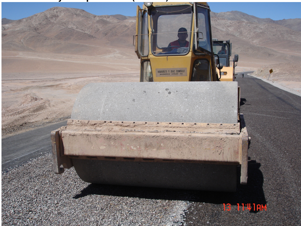
Figura 7: Rodillado y Compactación (Rodillo)
