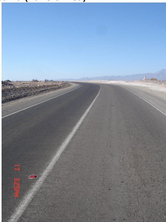
Figura 16: Construcción de infraestructura vial de enlace con Ruta 5 - El Olivar, Huasco Región de Atacama (Panorámica)
