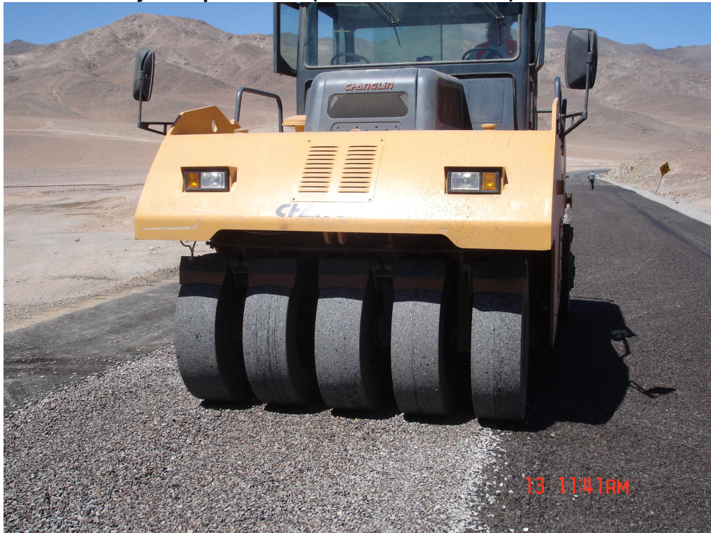
Figura 6: Rodillado y Compactación (Rodillo Neumático)
