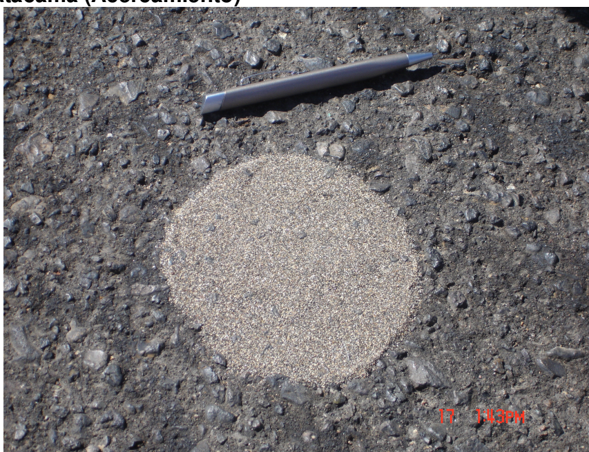
Figura 15: Construcción variante El Jilguero, Km. 0,000 al Km. 6,120 Huasco Región de Atacama (Acercamiento)
