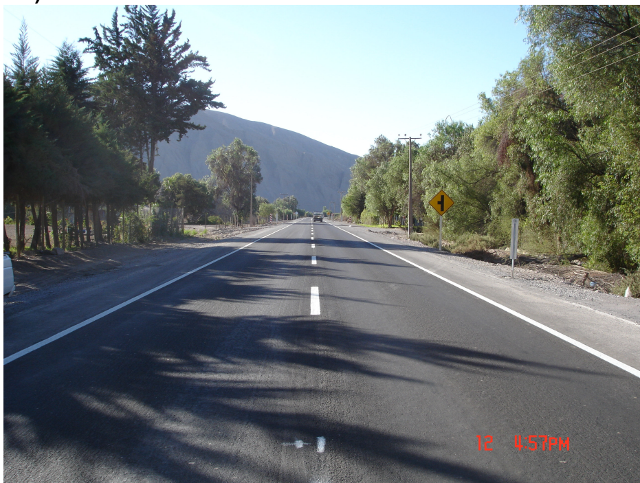
Figura 10: Reposición Ruta C-35, Cruce 31-CH Paipote -Juntas, sector Cerrillos - Los Loros, Km. 20,000 al 53,000, Provincia de Copiapó, Región de Atacama (Panorámica)
