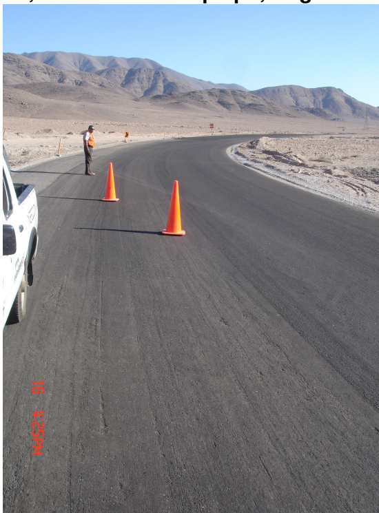
Figura 12: Conservación periódica Ruta C-17, sector Carrera Pinto - Chimberos, Km. 30,000 al Km. 60,000, Provincia de Copiapó, Región de Atacama (Panorámica)
