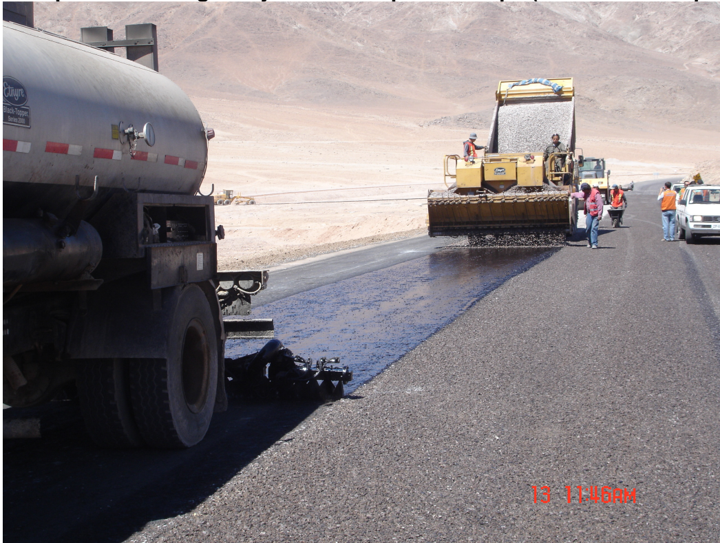
Figura 4: Aplicación de ligante y árido en la primera capa (Tratamiento Superficial)
