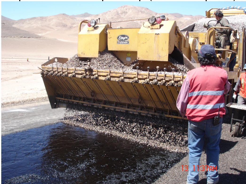
Figura 5: Aplicación de árido en la primera capa (Tratamiento Superficial)
