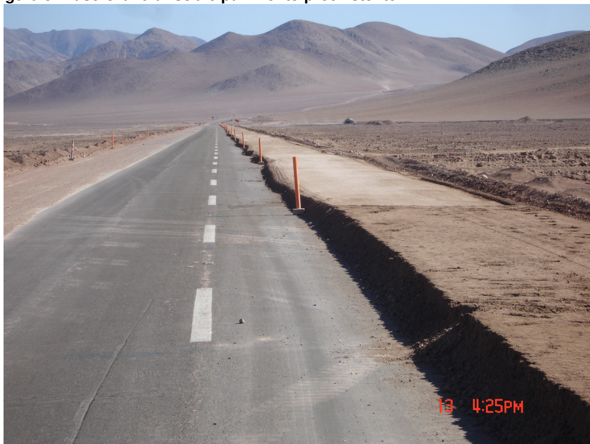
Figura 3: Base Granular sobre pavimento preexistente
