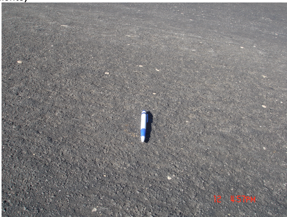
Figura 11: Reposición Ruta C-35, Cruce 31-CH Paipote -Juntas, sector Cerrillos - Los Loros, Km. 20,000 Al 53,000, Provincia de Copiapó, Región de Atacama (Acercamiento)
