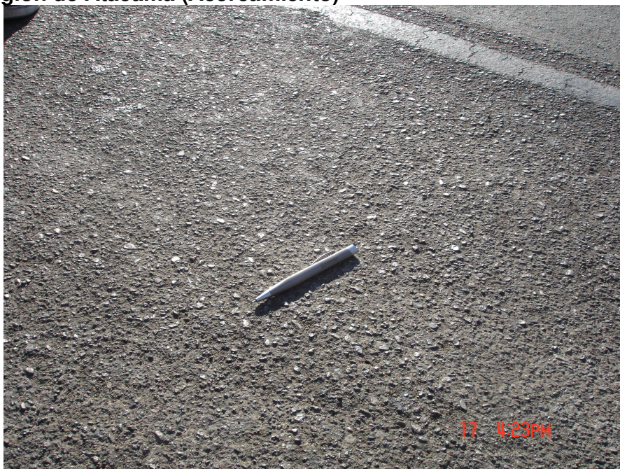
Figura 17: Construcción de infraestructura vial de enlace con Ruta 5 - El Olivar, Huasco Región de Atacama (Acercamiento)
