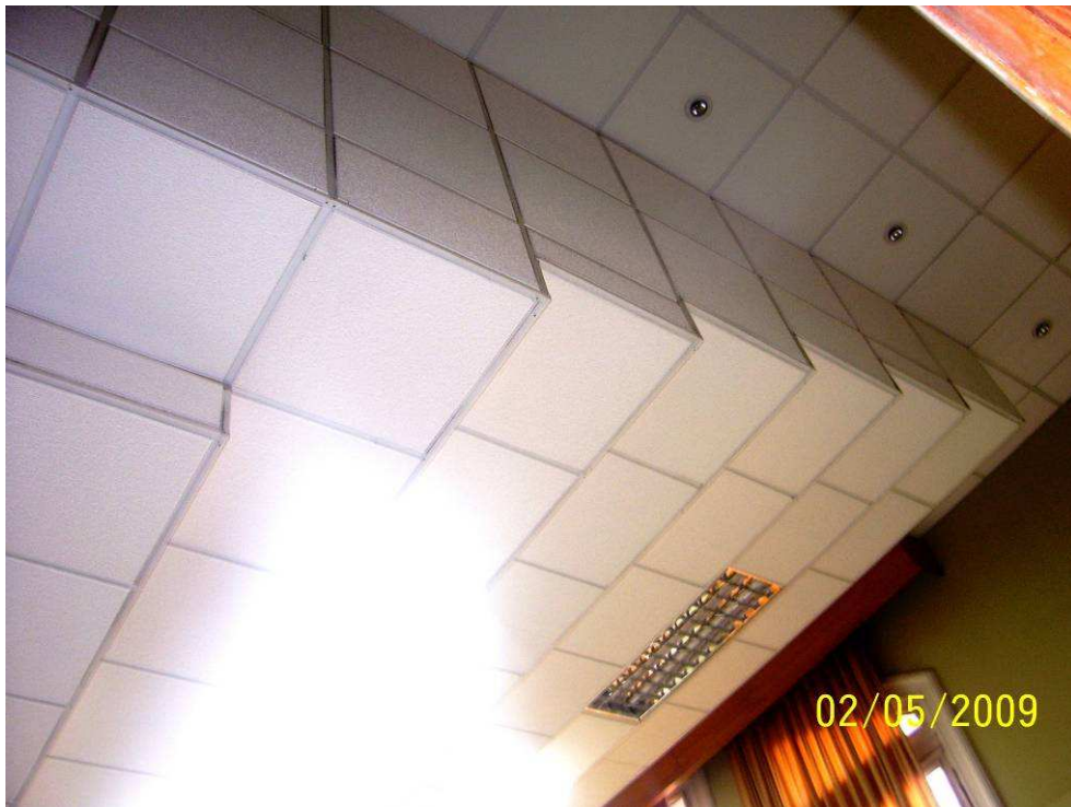
Fotografía B.12. Cielo falso dispuesto en forma escalonada.
