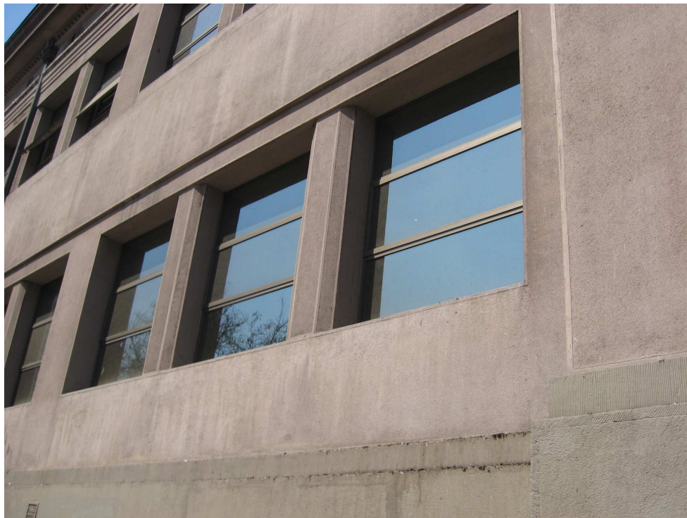
Fotografía B.27. Vista exterior sala de clases.
