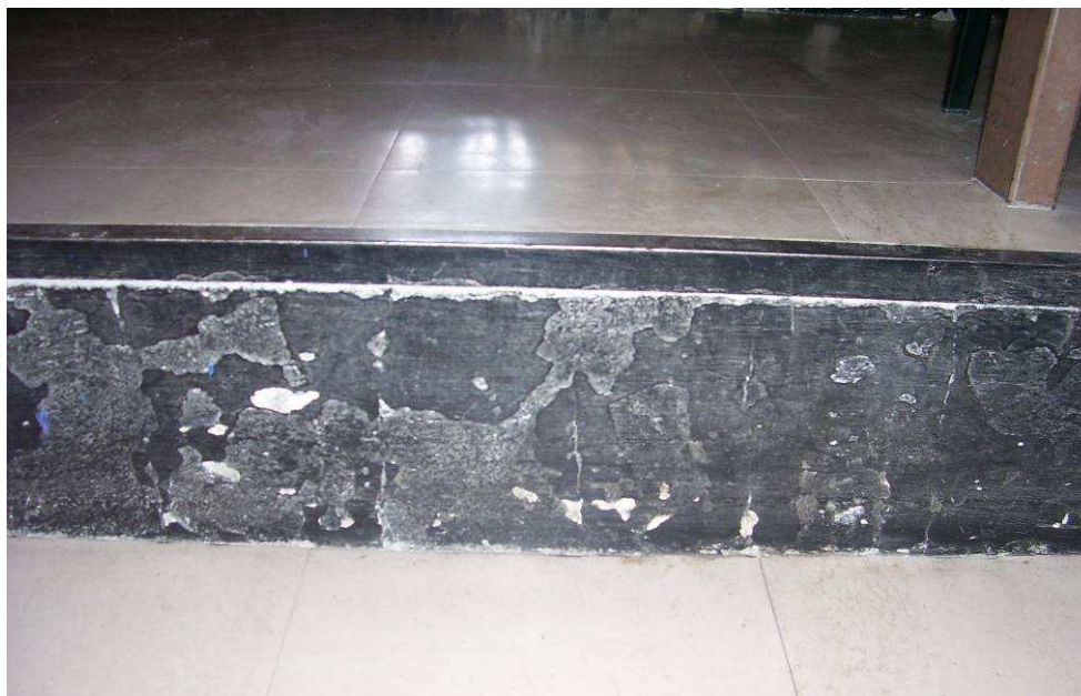
Figura N°6.12. Escalones sala Q10.
