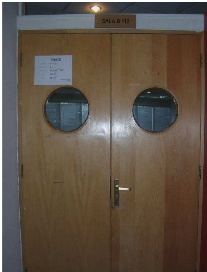
Fotografía B.9. Puerta entrada a sala.
