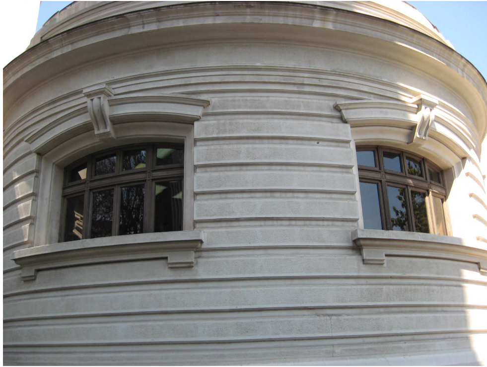
Fotografía B.23. Vista exterior sala de clases.
