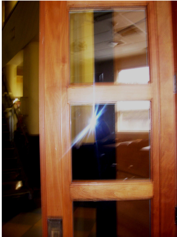
Fotografía B.26. Puerta ingreso a sala.
