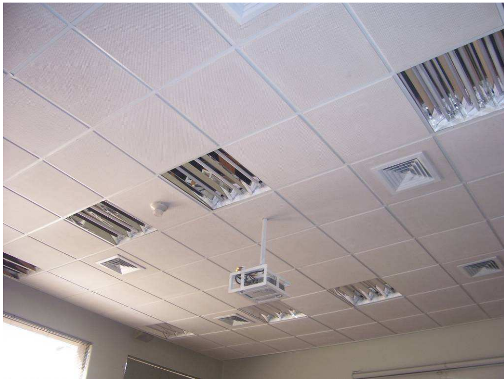
Fotografía B.25. Cielo falso.
