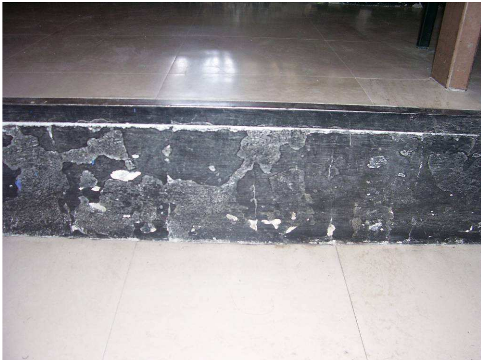
Fotografía B.20. Escalones y piso.
