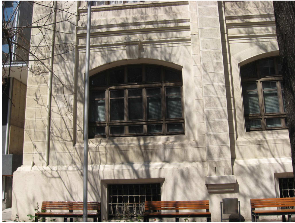
Fotografía B.18. Vista exterior sala de clases.
