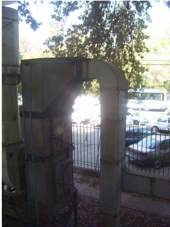
Fotografía B.17. Extractor a un costado del aula.
