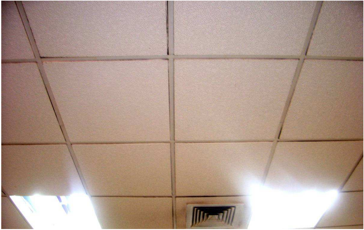
Fotografía B.7. Cielo falso.
