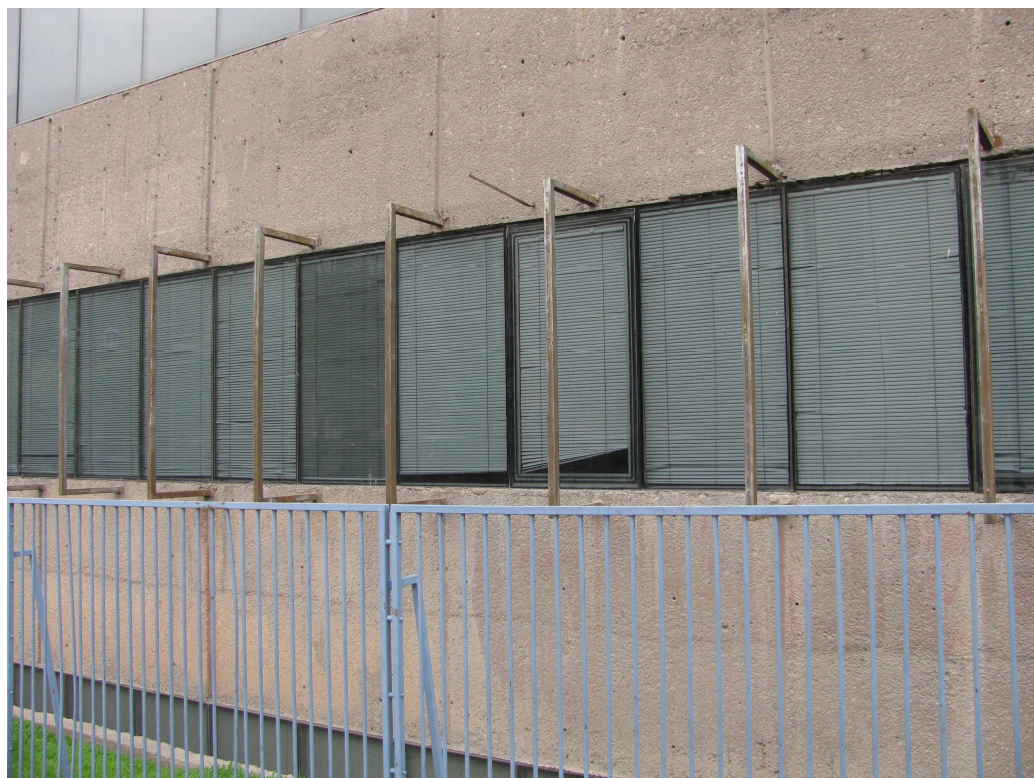
Fotografía B.10. Vista exterior sala de clases.
