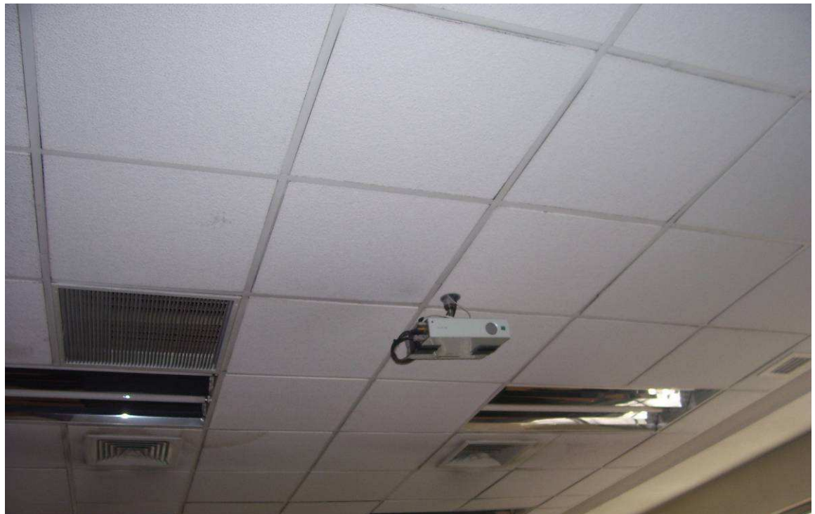
Fotografía B.2. Cielo falso.
