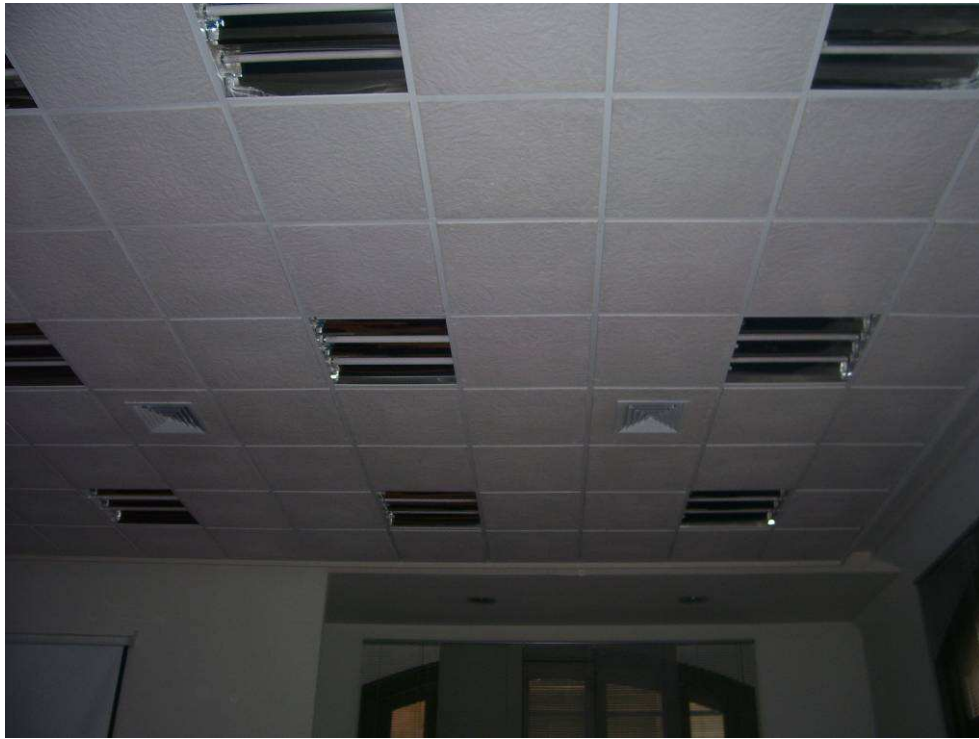
Fotografía B.14. Cielo falso.
