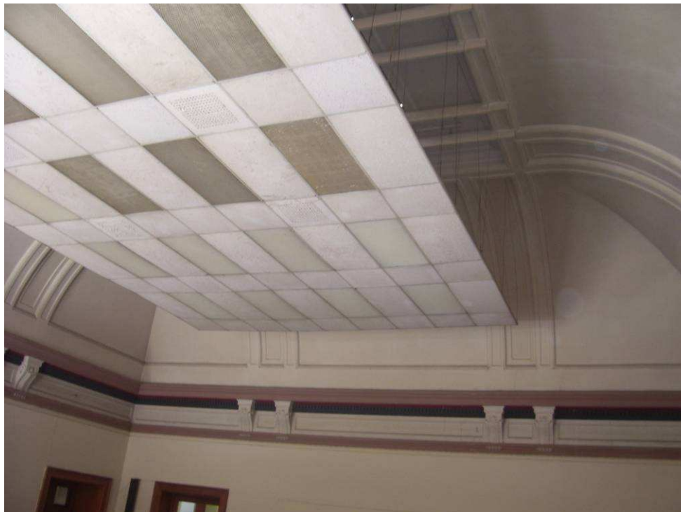
Figura N° 4.6. Cielo Sala Q10.
