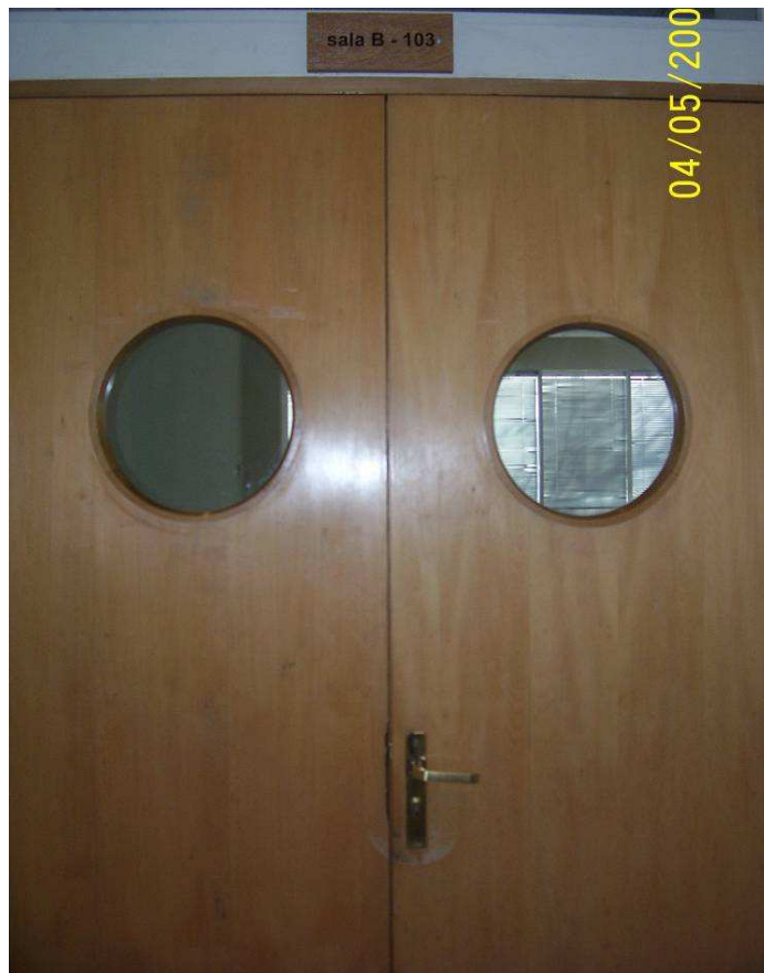
Fotografía B.3. Puerta entrada a sala.
