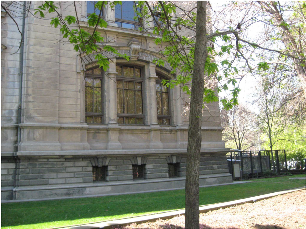
Fotografía B.13. Vista exterior sala de clases.
