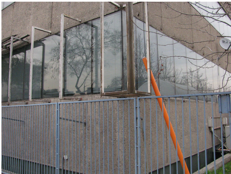
Fotografía B.4. Vista exterior sala de clases.
