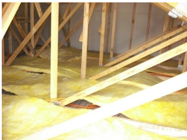
Figura 6.2.1.3.: Aislación térmica puesta erróneamente en cielo
