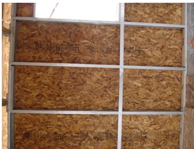
Figura 6.2.1.4.: Puentes térmicos a través de perfiles de aluminio
