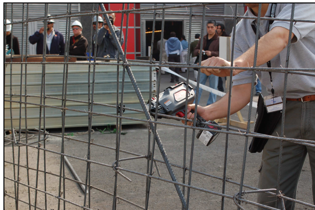
Figura N° 22: Utilización máquina enfierradora automática
