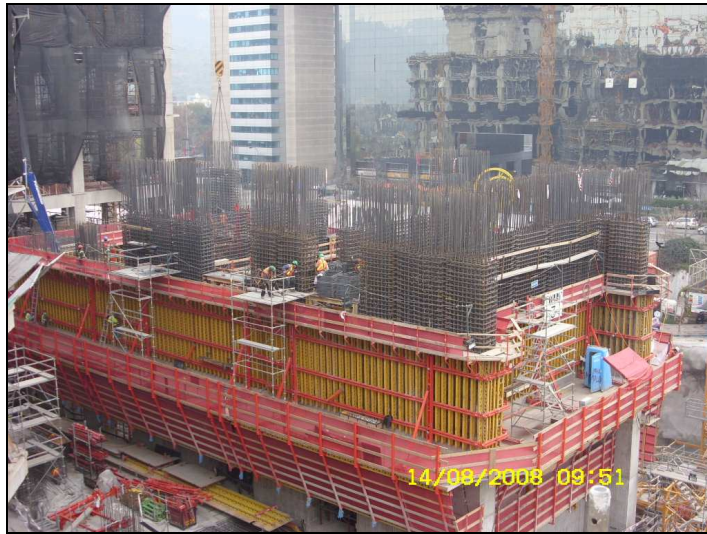
Figura N° 23: Edificio de gran altura con núcleo central.
