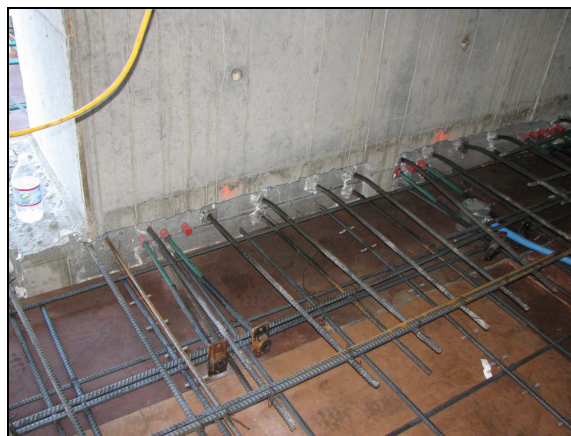
Figura N° 24: Muro con arranques para la unión con la losa.
