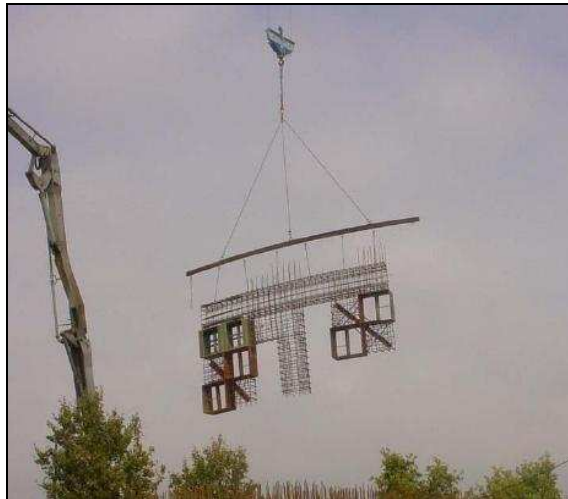
Figura N° 10: Canastillo elevado por una grúa [8]
