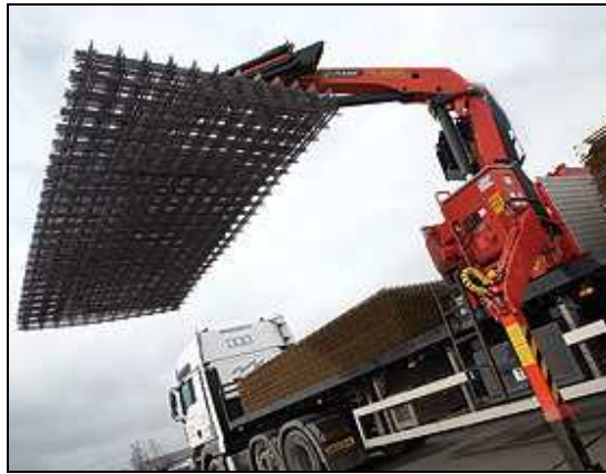
Figura N° 11: Transporte de armadura prefabricada [26].
