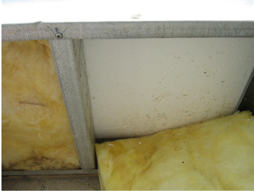
Figura A.5: Aislamiento térmico en los muros perimetrales de las viviendas.
