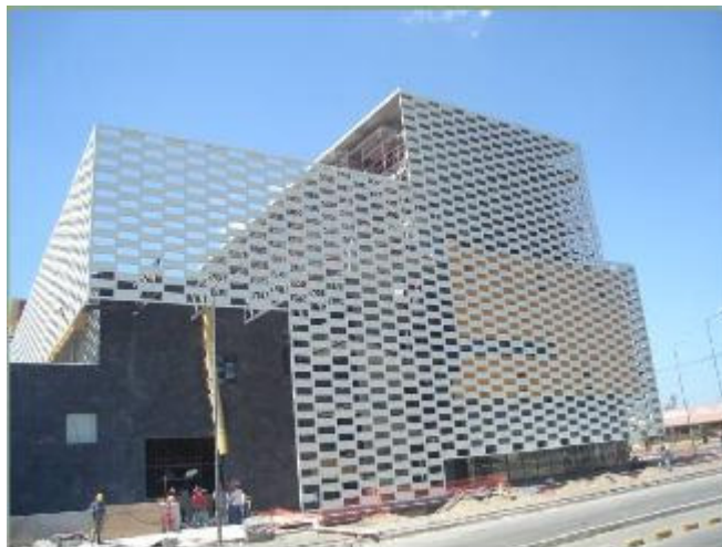
Construcción: Casino de apuestas Tipo de muro: Fachada con sistema EIFS Superficie Instalada: 5000 m 2 Zona: Talca
