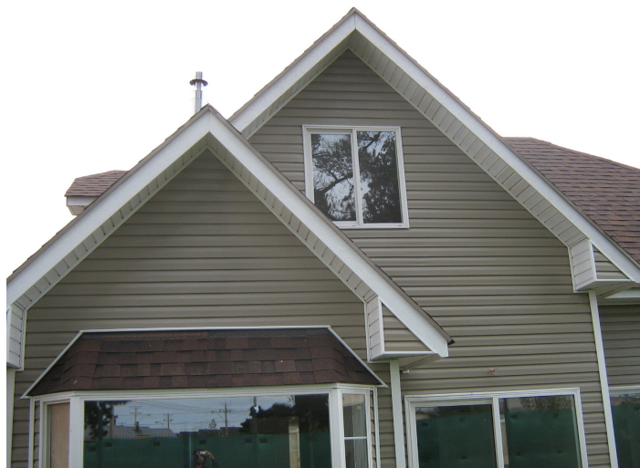
Figura A.2: Fachada oeste de la vivienda 1
