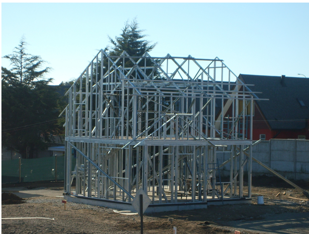
Figura 6.8: Fase de construcción del Sistema Estructural de las viviendas.
