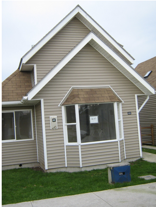
Figura A.1: Fachada oeste de la vivienda 3.
