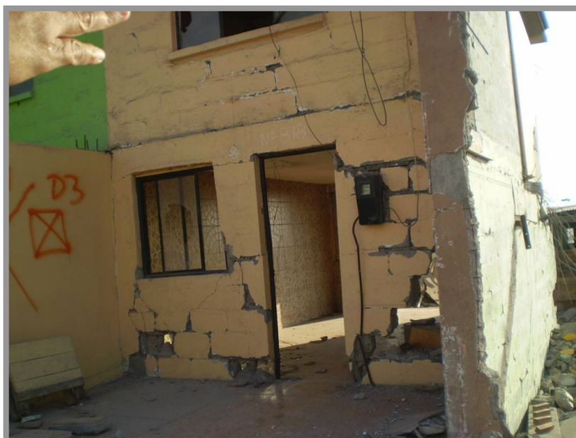
Figura 4.29 Daños en eje 1 (Casos 230a al 230e).
