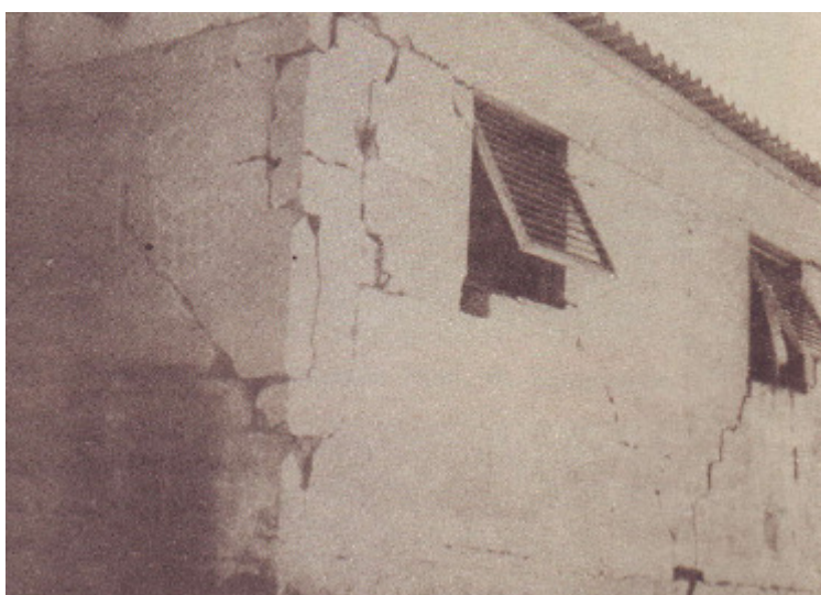
Figura 4.6 Daños en un Cuerpo 1 (Caso 210)
