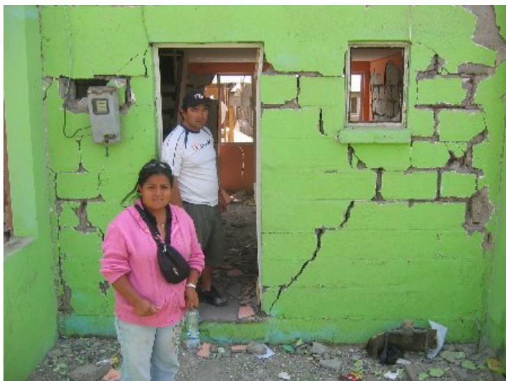
Figura 4.33 Daño de la figura anterior, desde el exterior de la vivienda (Casos 240a al 240d).
