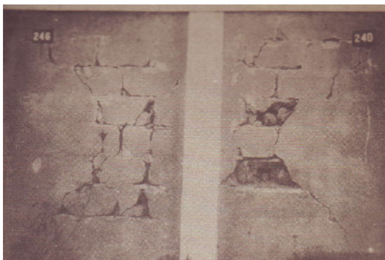
Figura 4.12 Daños en eje 3 (Caso 220)
