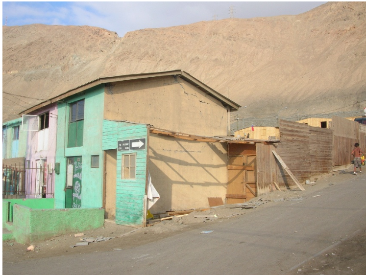
Figura 4.35 Daños en muros de la dirección Y de la planta (Casos 240a al 240d)
