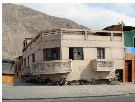
Estado después del terremoto
