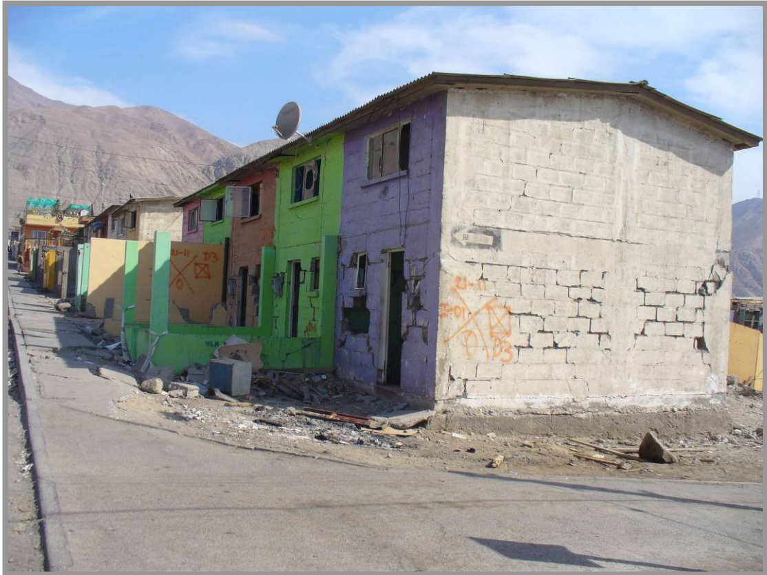
Figura 4.27 Daños en ejes B y 3 de un tren de cinco viviendas (Caso 230d).
