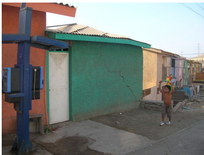
Figura 4.34 Daño en ampliación de la vivienda (Casos 240a al 240d)
