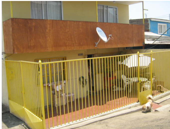
Figura 4.45 Vista de una vivienda modificada (Caso 250b).
