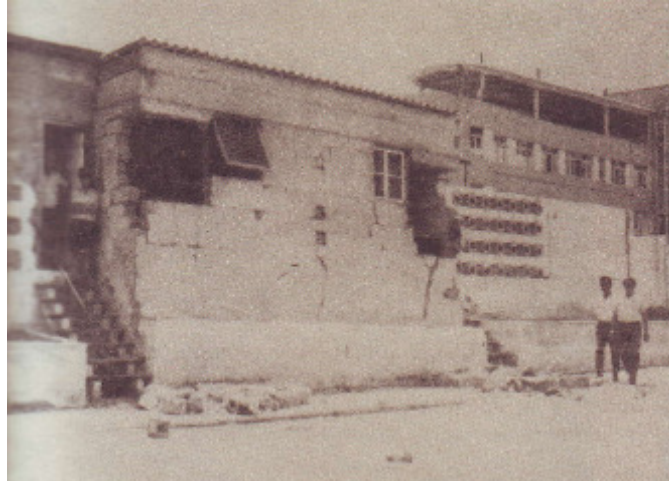
Figura 4.7 Daños en un Cuerpo 1 (Caso 210) (2)
