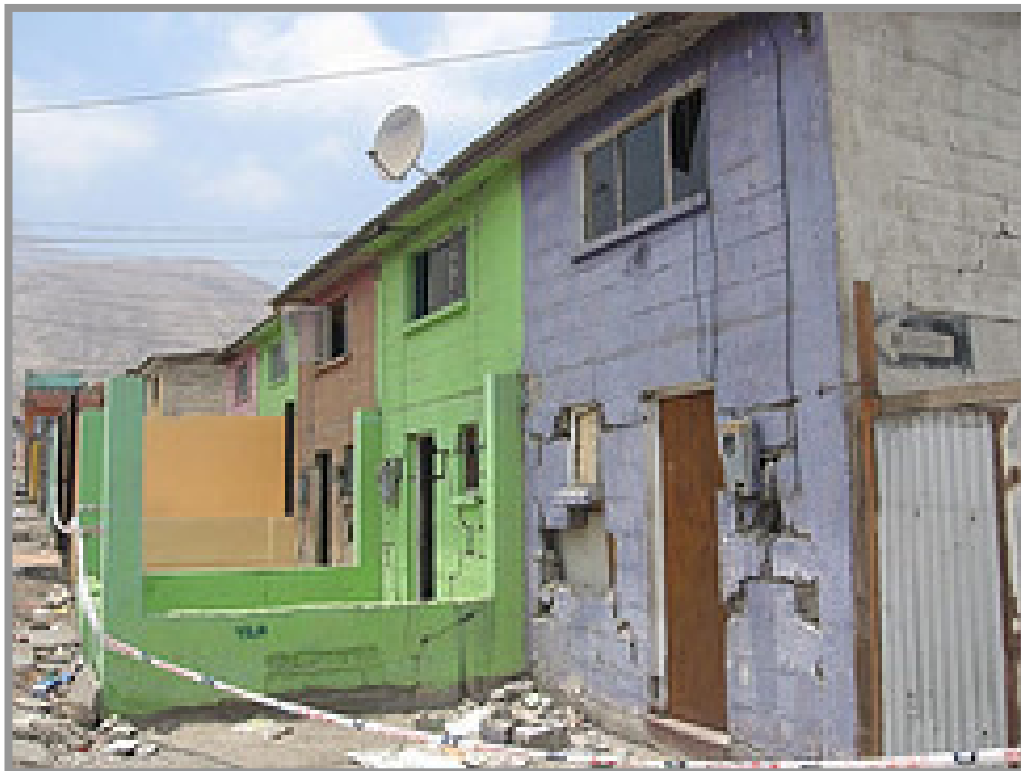
Figura 4.28 Daños en eje 3 de un tren de 3 viviendas (Caso 230b).
