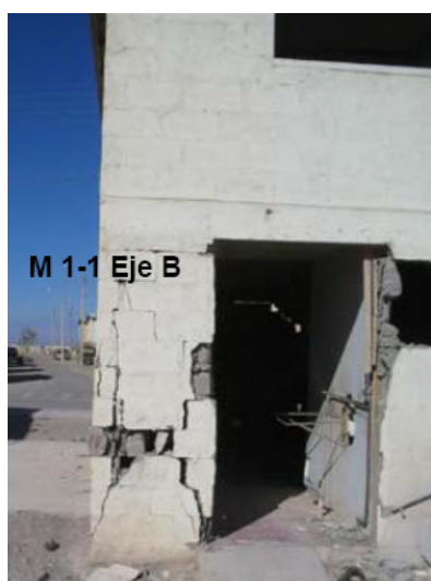
Figura 4.23 Daños en eje B (Caso 112).
