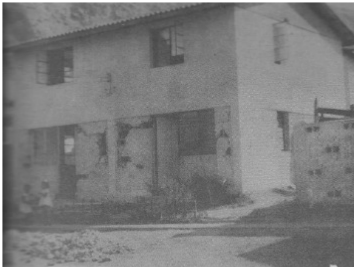
Figura 4.11 Daños en eje A (Caso 220)
