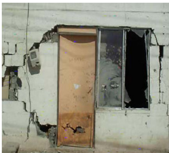
Figura 4.22 Daños en eje A (Caso 112) (2).
