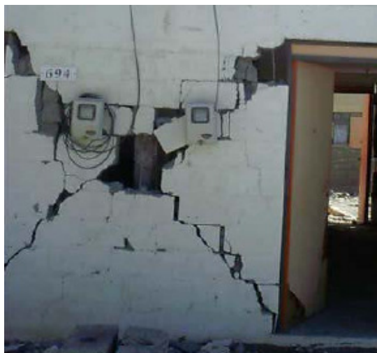
Figura 4.21 Daños en eje A (Caso 112)
