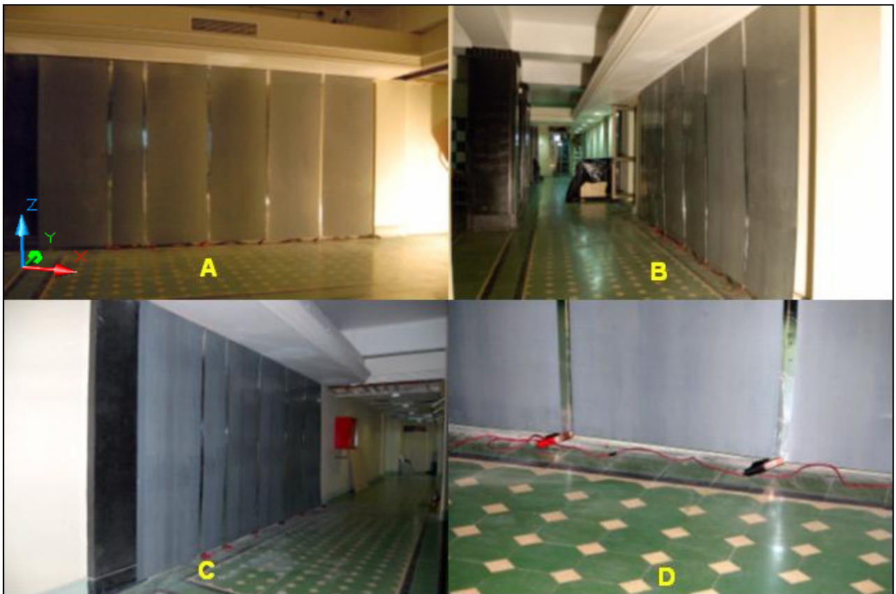
Figura 6.1: Blindaje del muro Norte de la Sala TEM mediante láminas de Fierro Silicoso de Grano Orientado M-4. A) Vista frontal al muro Norte Sala TEM. B) Vista lateral de Poniente a Oriente. C) Vista lateral de Oriente a Poniente. D) Detalle del sistema de puesta a tierra y acoplamiento entre las placas mediante cinta autoadhesiva de aluminio.
