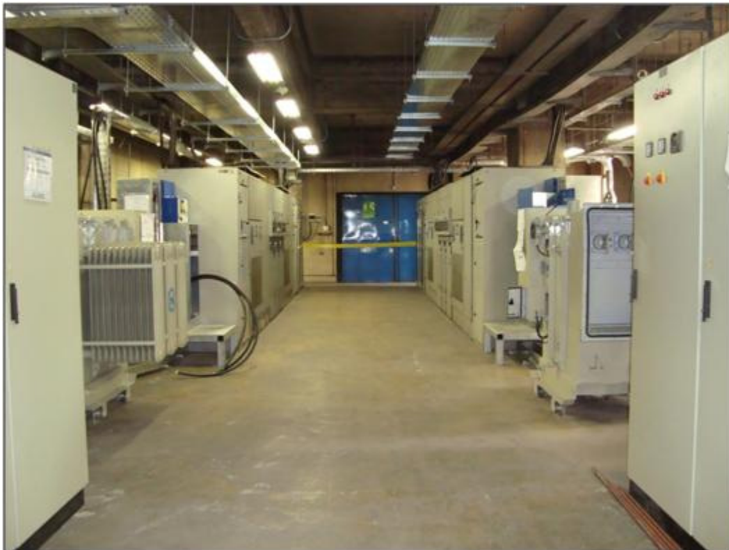
Figura 41: Galería de interruptores, quinto piso edificio Metro.
