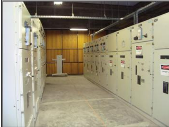
Figura 40: Galería de interruptores, quinto piso edificio Metro.
