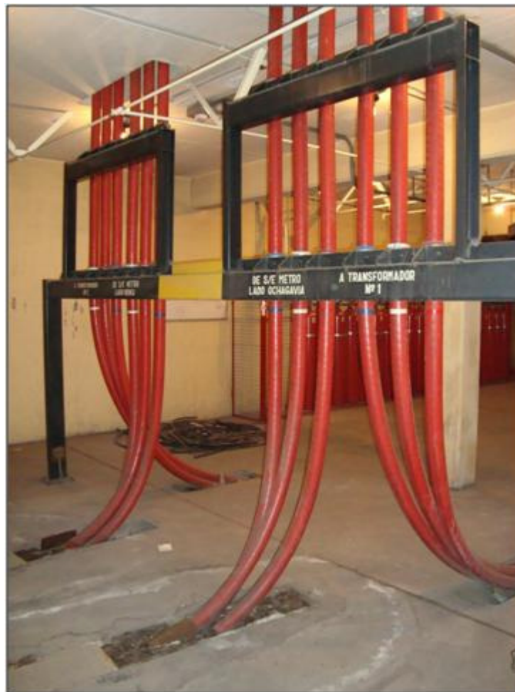
Figura 32: Sala bajo sala de 110 kv Gis.
