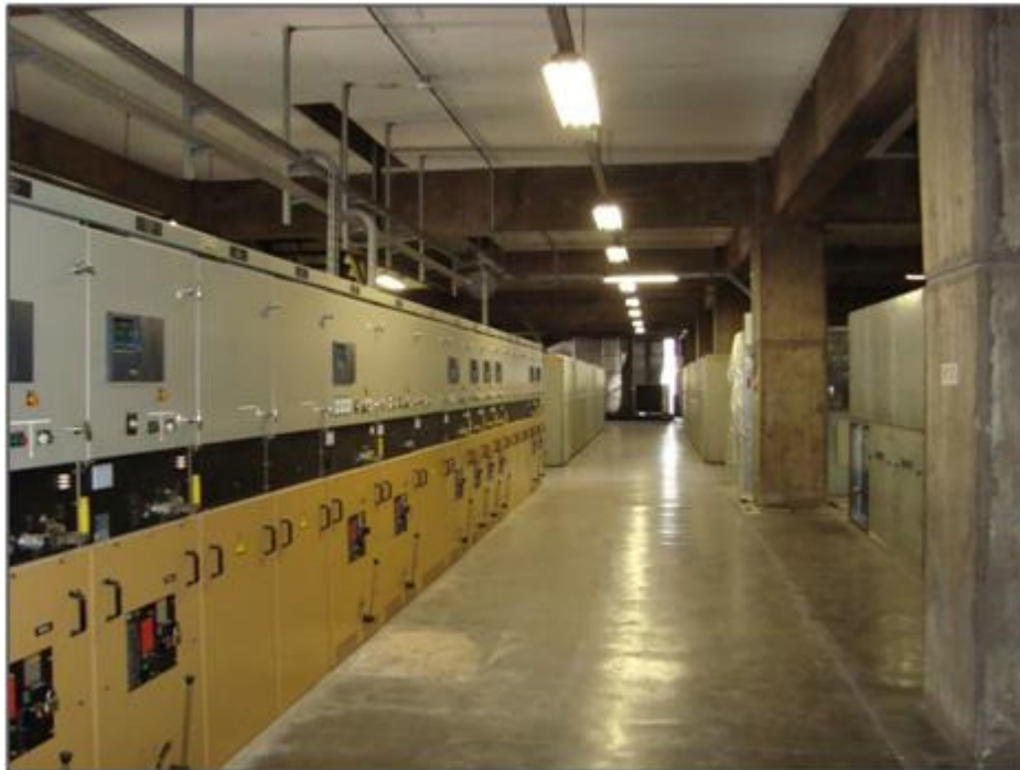
Figura 38: Galería de alimentadores, quinto piso edificio Metro.
