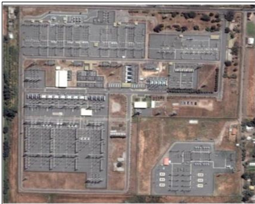
Figura 7: Vista Satelital Instalaciones S/E Alto Jahuel, Transelec Chile.
