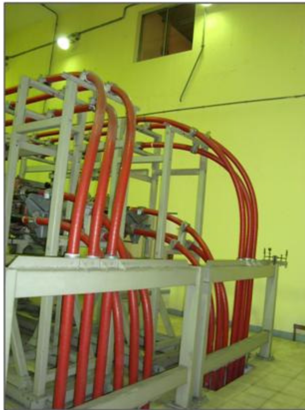
Figura 30: Cables de poder 110 kV.
