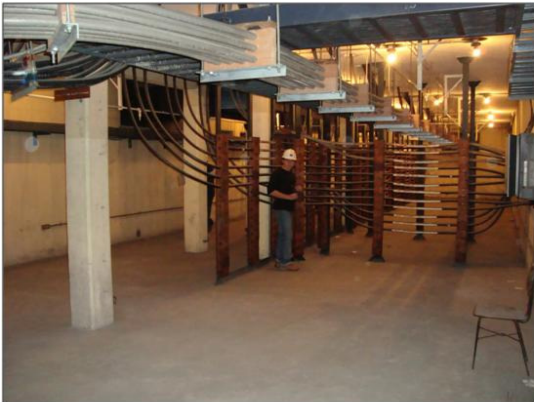
Figura 34: Sala de alimentadores de 12 kV.
