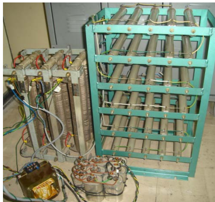
Figura c.7: Banco trifásico de cargas.
