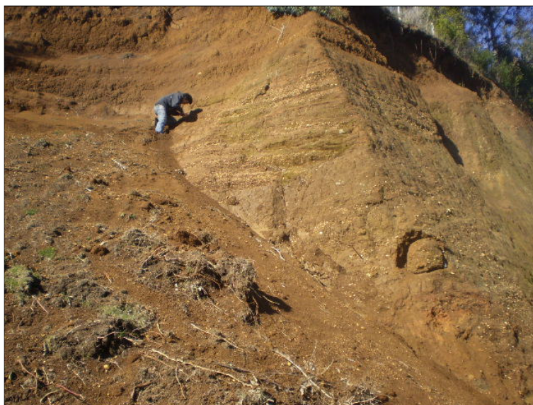
Figura 41: Talud y discontinuidades del Sector 3
