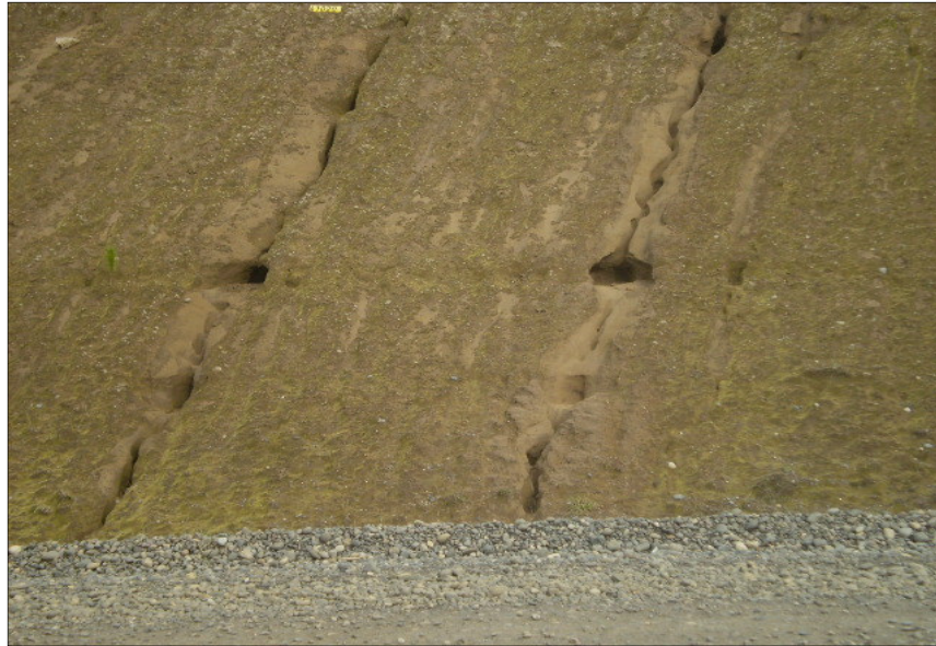
Figura 6: Erosión por cárcavas en un talud (Tranapunte, IX región)
