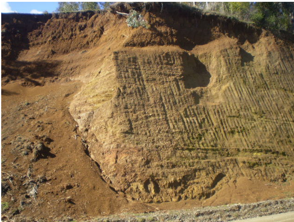
Fotografía 2: Talud, Sector 3 (Tranapunte-Tirúa, IX Región)
