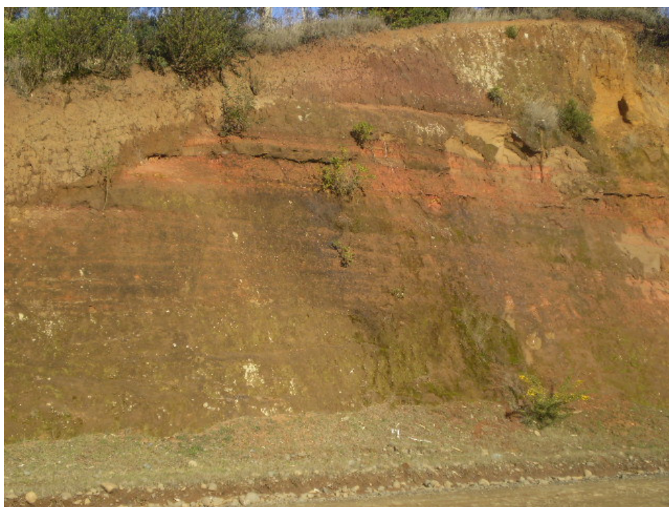
Fotografía 3: Talud, Sector 4 (Tranapunte-Tirúa, IX Región)
