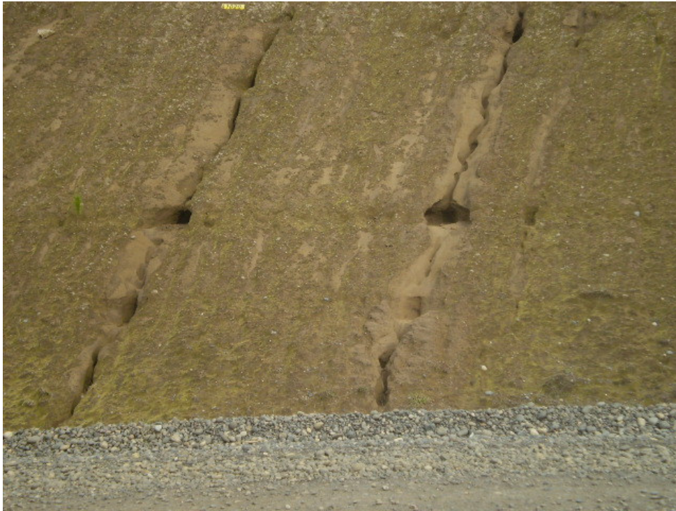
Fotografía 1: Talud erosionado, Sector 2 (Tranapunte-Tirúa, IX Región)
