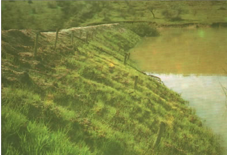
Figura 9: Talud protegido con Vegetación (Marienberg)
