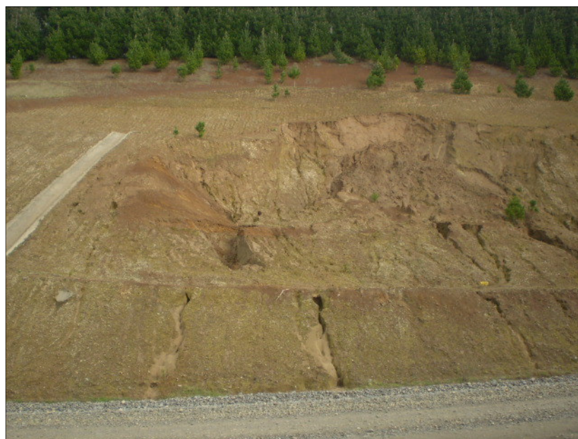
Figura 1: Surcos y cambios de geometría en un talud debido a la erosión (Sector Tranapunte, IX región)
