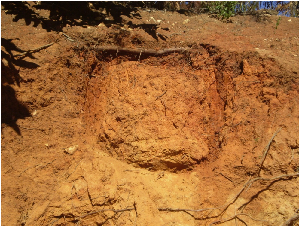
Fotografía 6: Talud, Muestra Roja, Camino La Pólvara
