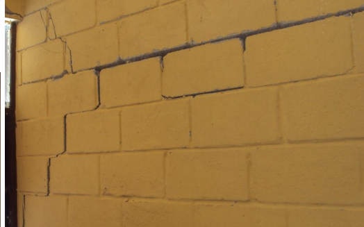
Figura 3. 20. Falla tipo observada en muros medianeros
