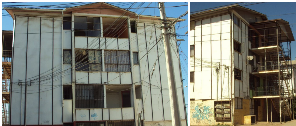
Figura 3. 2. Recubrimientos externos de los edificios para protegerlos de la humedad
