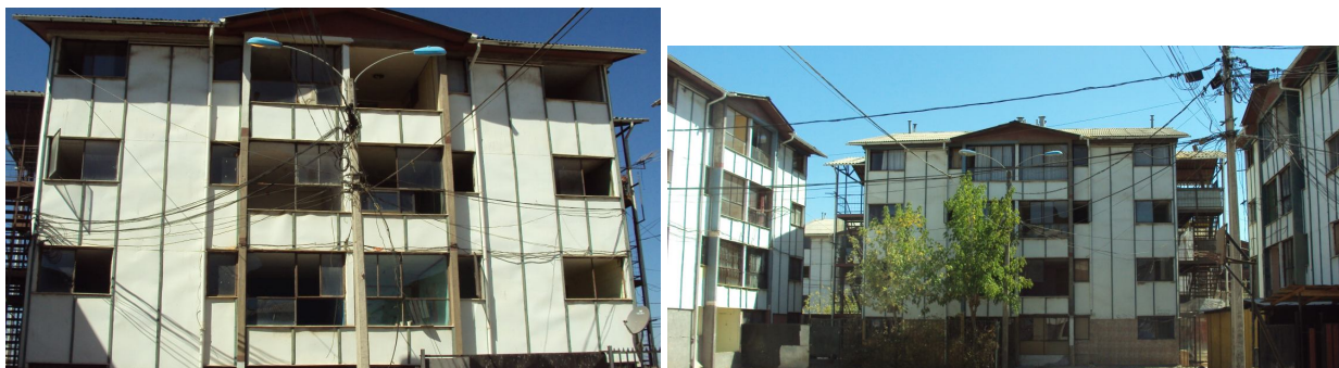
Figura 3. 22. Recubrimiento colocado en edificios debido a filtraciones de aguas lluvia
