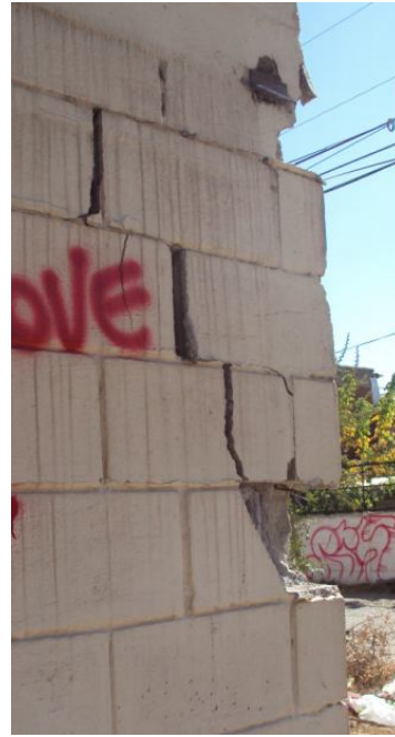
Fotos de daños producidos por el terremoto en el encuentro de muros:
