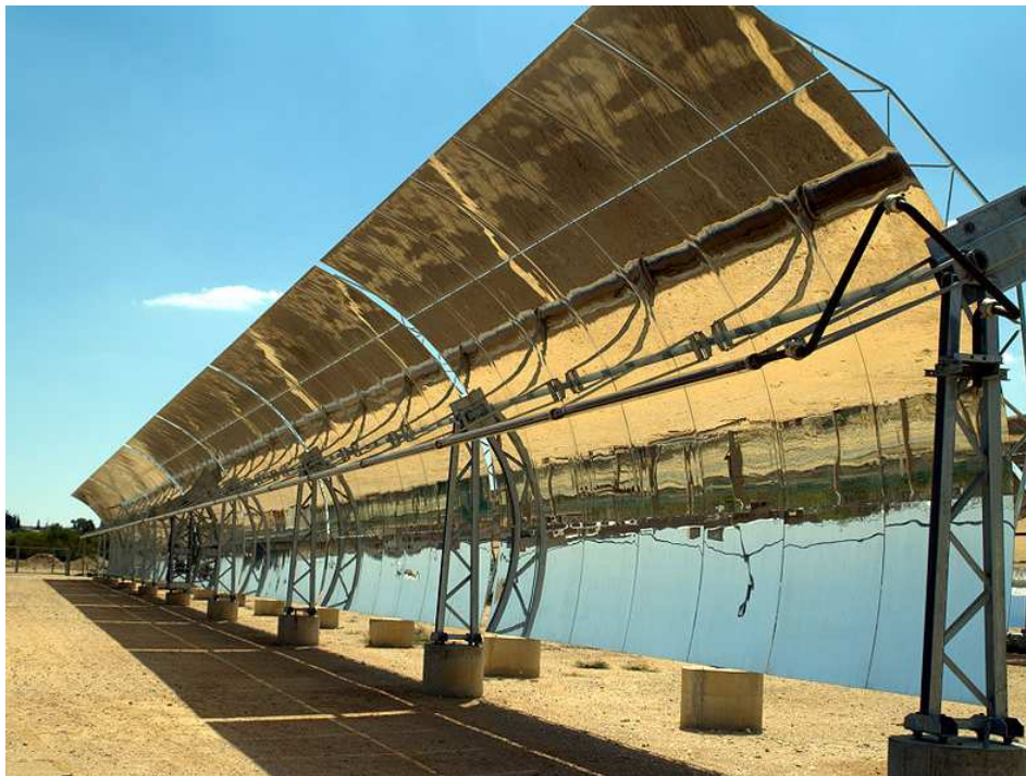
Imagen 1.4: Paneles cilindro parabólicos en el desierto de Negev, Israel [24].
