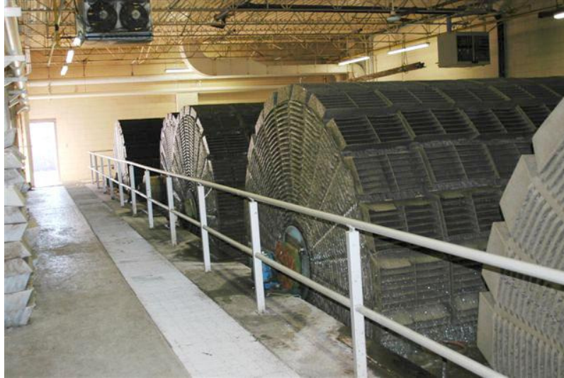
Figura 3.2.3 Biodiscos
