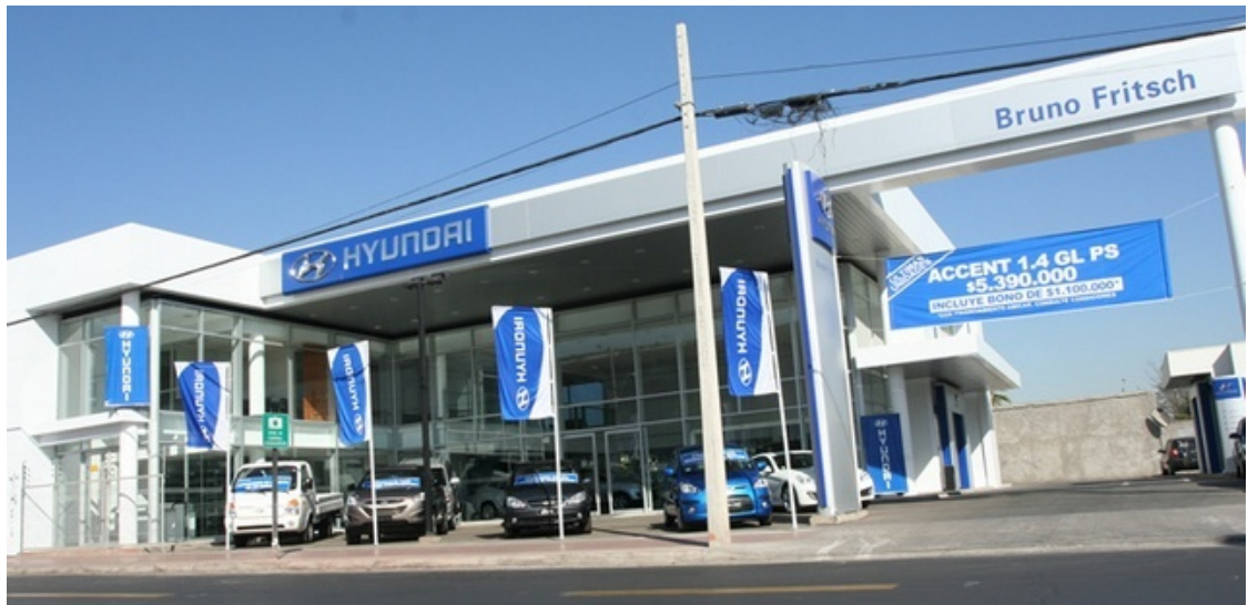
Figura 15. Centro de Servicio Automotriz y Local de Venta de Automóviles. (Fuente: www.brunofritsch.cl ; consulta: mayo 2011)
