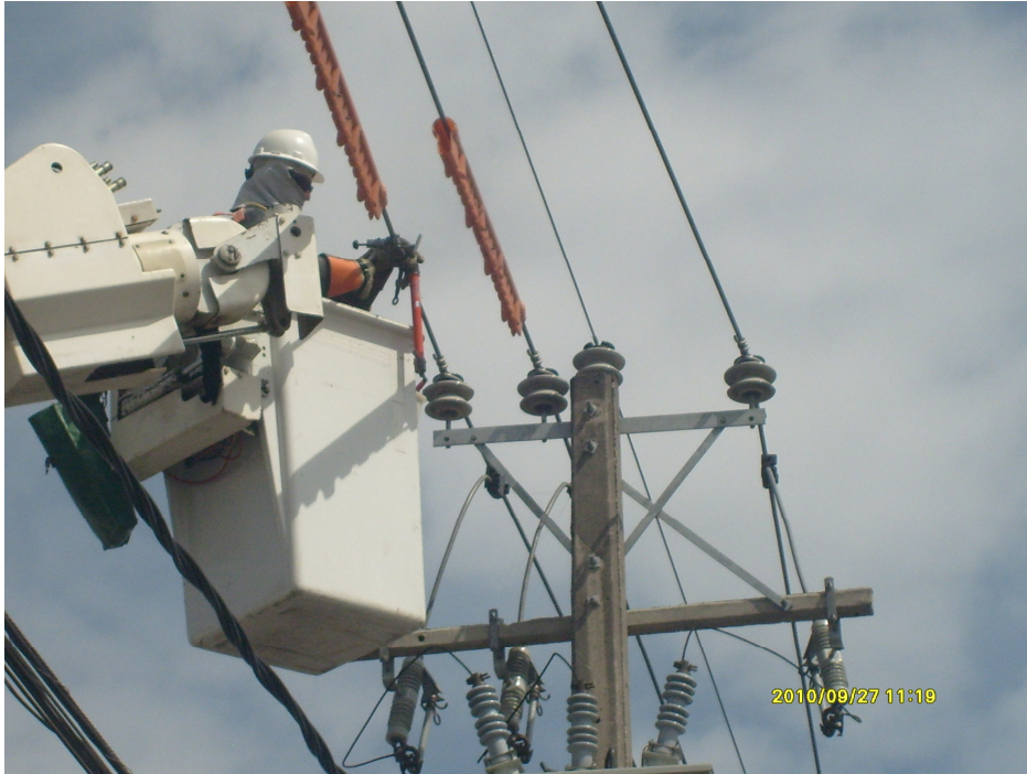
Figura 2. Otros ejemplos de trabajo en líneas eléctricas de alta tensión
