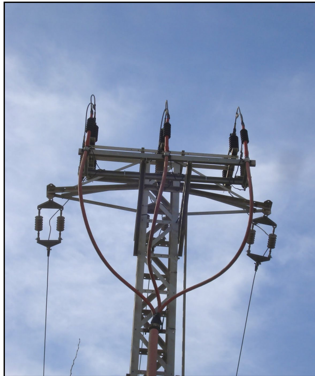
Figura 3. Empalmes eléctricos en una línea de alta tensión
