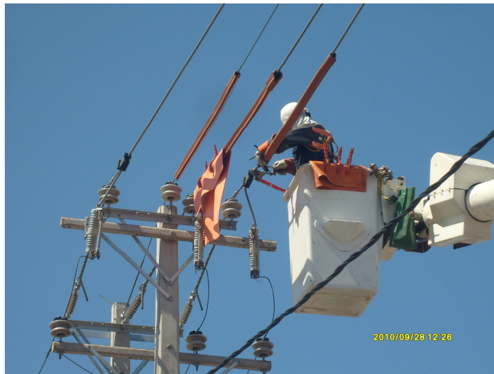
Figura 1. Trabajo en líneas eléctricas de alta tensión en altura
