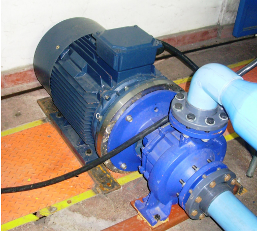
(a) Bomba centrífuga y motor eléctrico.
