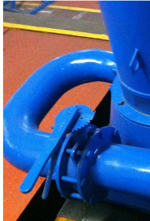
Figura 4.10: Mecanismo de regulación original para apertura de válvula mariposa secundaria.
