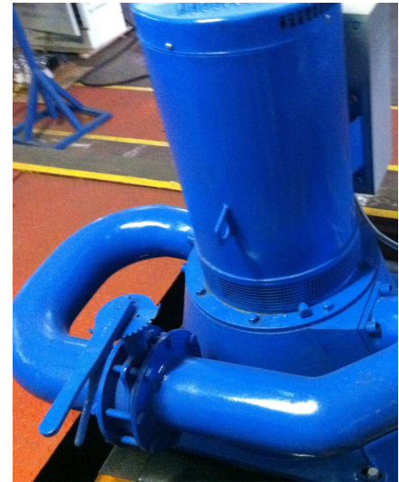
Figura 3.7: Válvulas mariposa principal y secundaria para regulación de caudal. [Elaboración propia]
