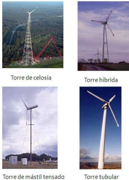
Figura 2.4: Tipos de Torres para aerogeneradores
