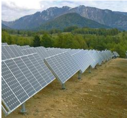
Figura 2.18: Paneles solares sobre es estructuras fijas.
