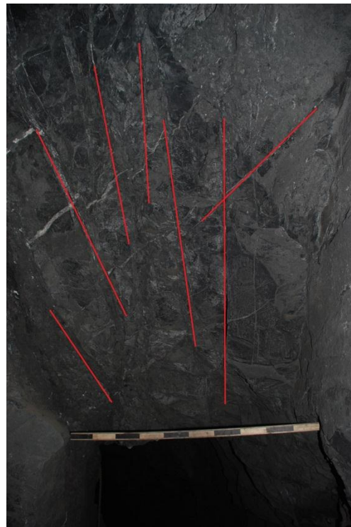
Figura 13 Mapeo PC-18 vista techo bloque medido
