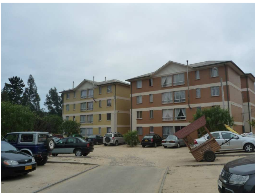
- Figura E18: Fachada
