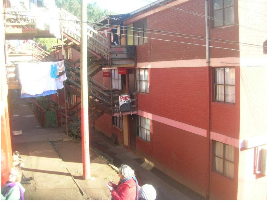
Figura E15: Fachada
