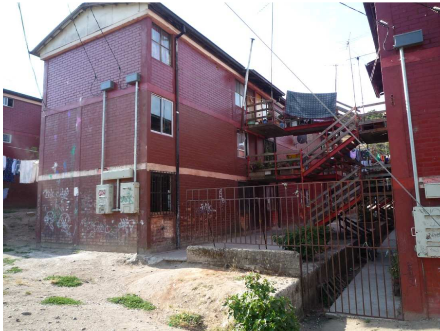
Figura E6: Fachada
