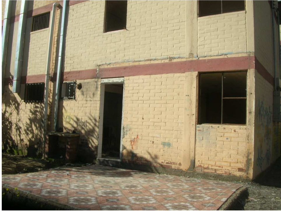
Figura E8: Fachada con eliminación de antepecho y apertura de ventana en el muro
