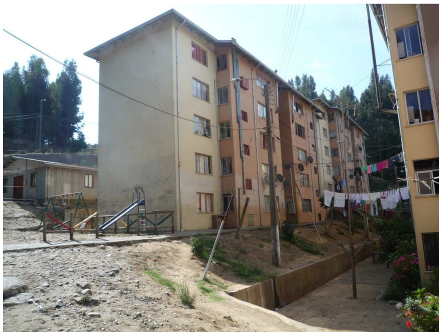
Figura E17: Fachada
