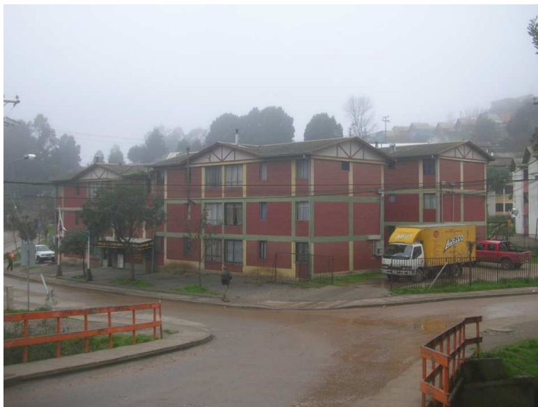
Figura E22: Fachada
