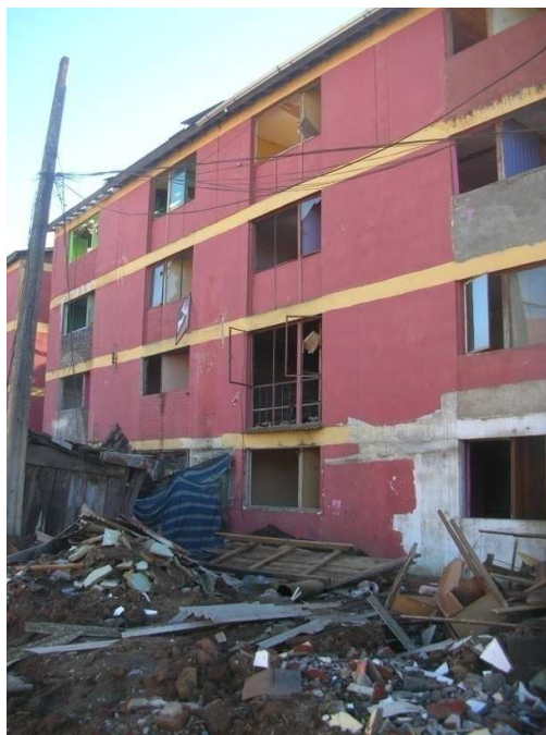
Figura E10: Fachada donde se observan antepechos de diferentes materiales (latón, hormigón y ladrillo)
