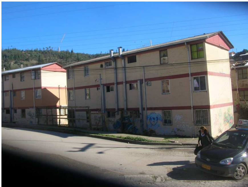
Figura E7: Fachada
