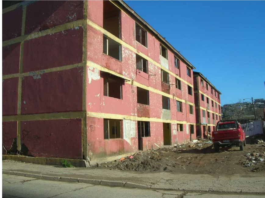
Figura E11: Fachada
