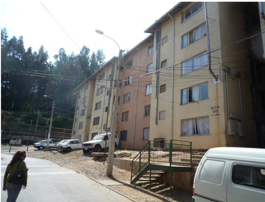
Figura E16: Fachada
