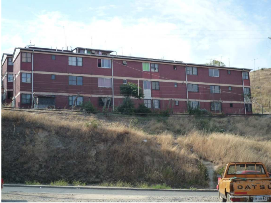
Figura E6: Fachada
