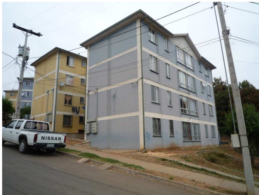
Figura E24: Fachada
