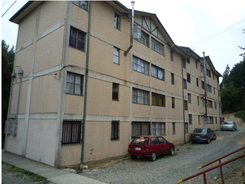
Figura E23: Fachada
