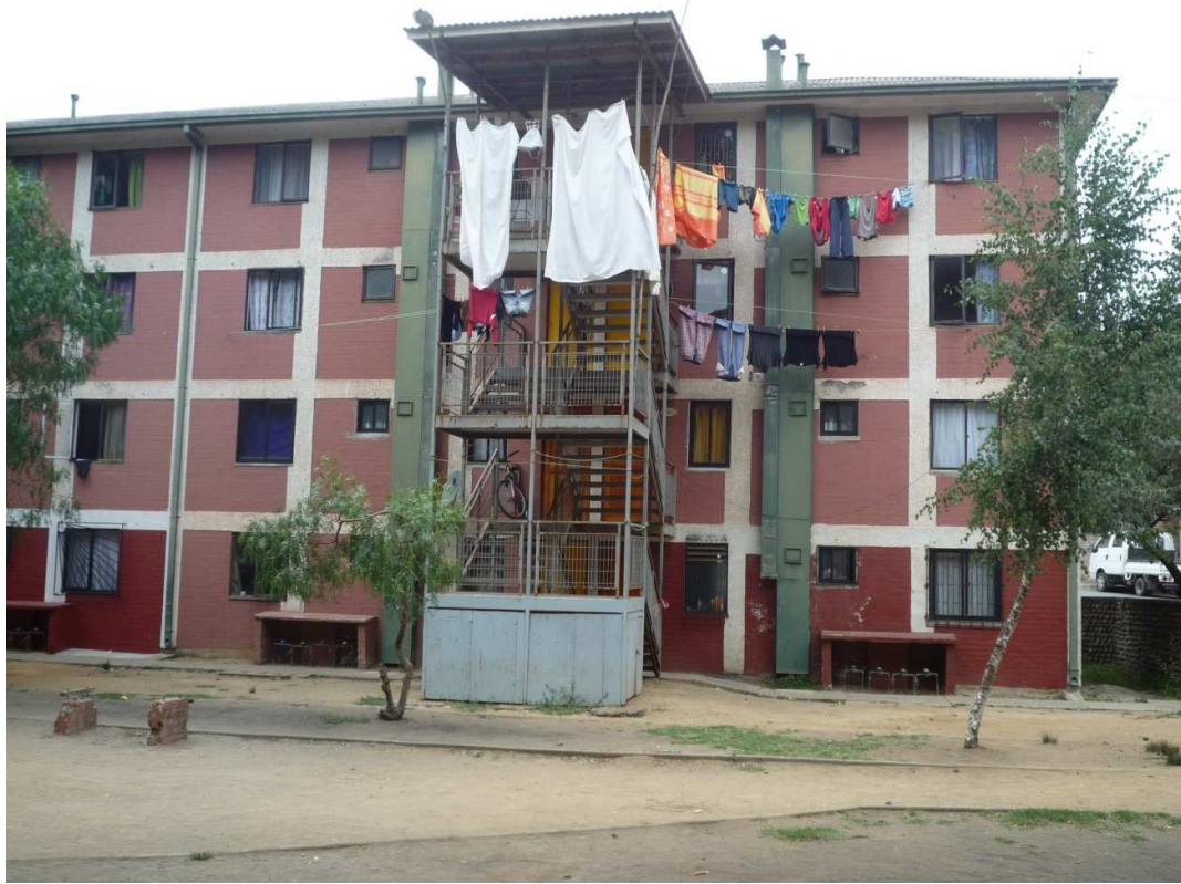
Figura E24: Fachada
