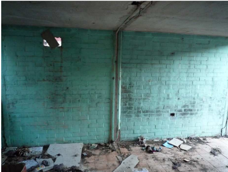
Figura 19: Muro exterior de albañilería confinada sin daño. Ladrillos faltantes no están relacionados con el evento sísmico y el estuco central era usado como apoyo para tabique en dirección perpendicular.
