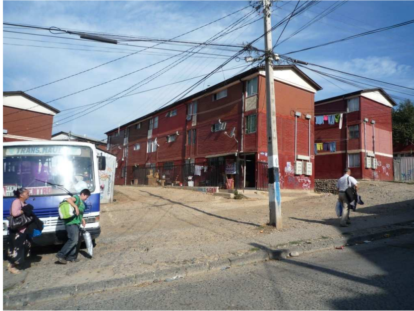
Figura E5: Fachada con eliminación de antepecho
