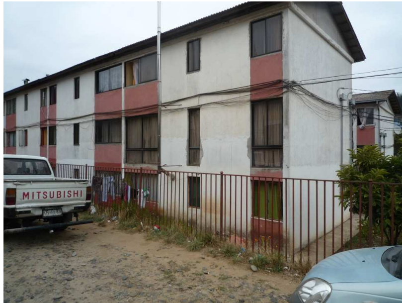
Figura E19: Fachada con antepechos eliminados
