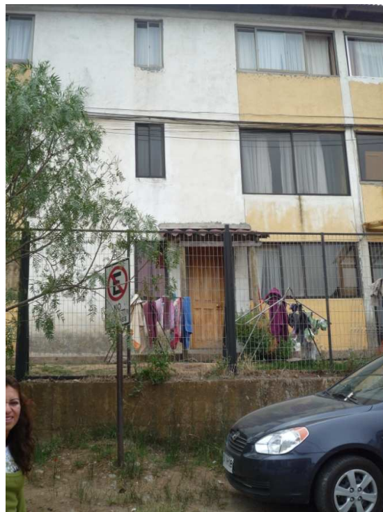
Figura E20: Fachada con abertura de puerta en un muro
