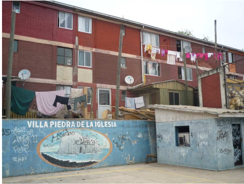
Figura E13: Fachada donde se observa abertura de puerta en el muro
