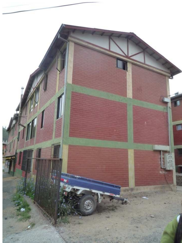
Figura E21: Fachada con abertura de ventana en un muro transversal
