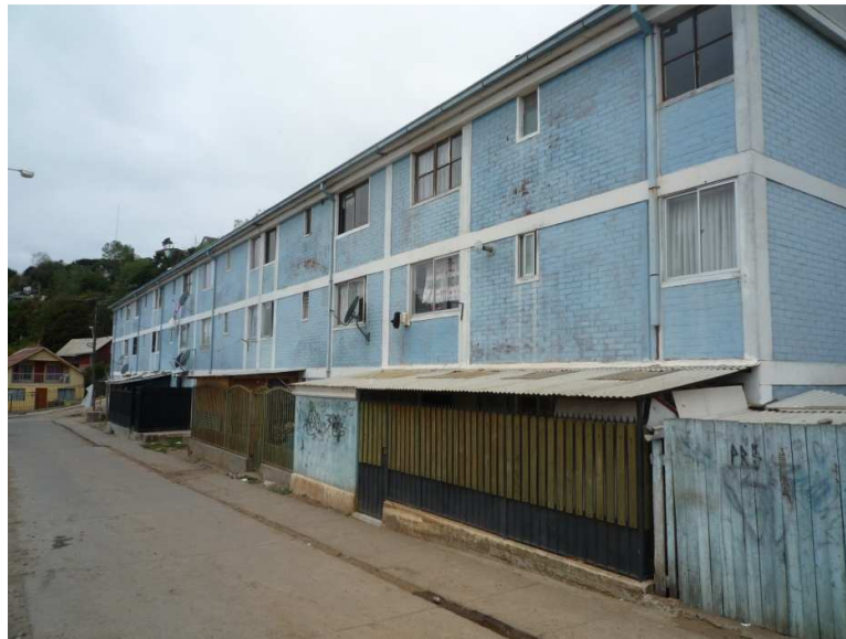
Figura E14: Fachada
