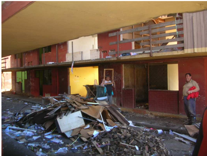
Figura E12: Fachada
