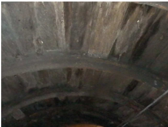
Figura 54: Interior pique de acceso mina Tequendama
