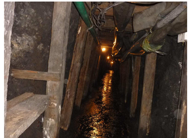
Figura 55: Vista de mangas de ventilación
