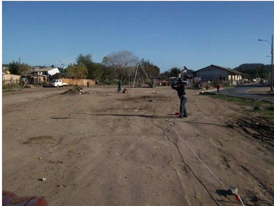
Fotografía 12: Ejecución de golpes con el combo de 12.5 kg en la medición del subsuelo de la Estación de Constitución. De fondo se puede ver el trípode desplegado
