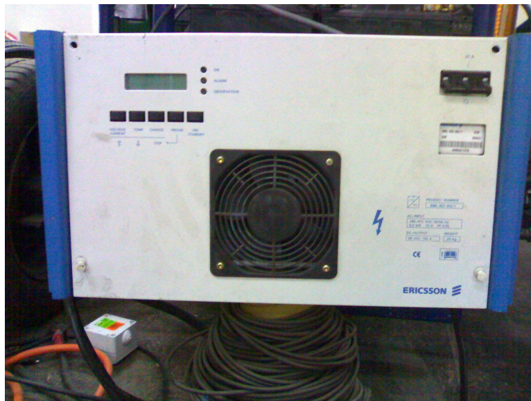
Figura 7.19: Banco de baterías y cargador utilizados como fuente de tensión continua para alimentar controlador Alltrax
