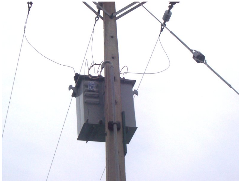
Figura 4.2: Punto de conexión con la compañía distribuidora. El punto incluye el transformador de bajada, un medidor de energía, y un interruptor termomagnético.
