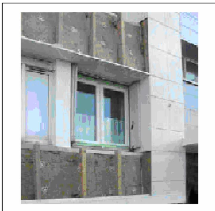
**Fig. N° 14: Colocación de cerámicos sobre estructura de madera**
