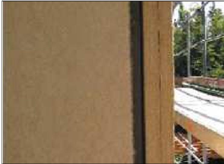
**Fig. N° 27: Esquina de muros en la que se muestra que no existe un perfil o elemento que una el encuentro. Esto puede permitir el paso del agua y provocar daños en caso de impacto.**
