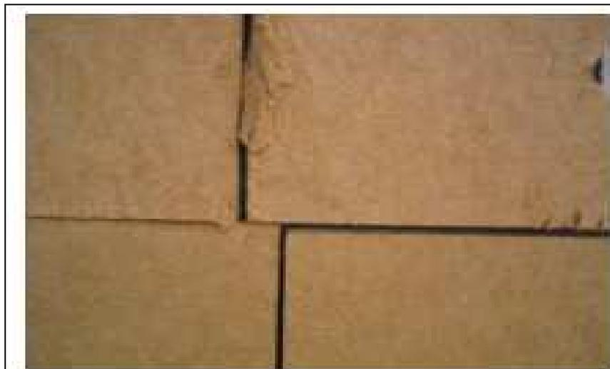
**Fig. N° 28: Cuando las juntas no quedan bien realizadas, al haber desplazamientos, se puede provocar deterioros en las placas tal como muestra la imagen y permitir el paso del agua.**
