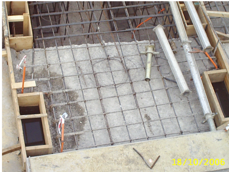
Figura 21. Fotografía que muestra el poco control posterior a la ejecución de las obras. (Exceso de humedad, armadura sin protección)
