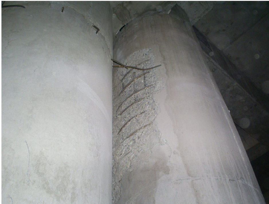
Figura 19. Fotografía que muestra el trabajo mal ejecutado. (Armadura sin una adecuada protección, expuesta a humedad y deterioro)
