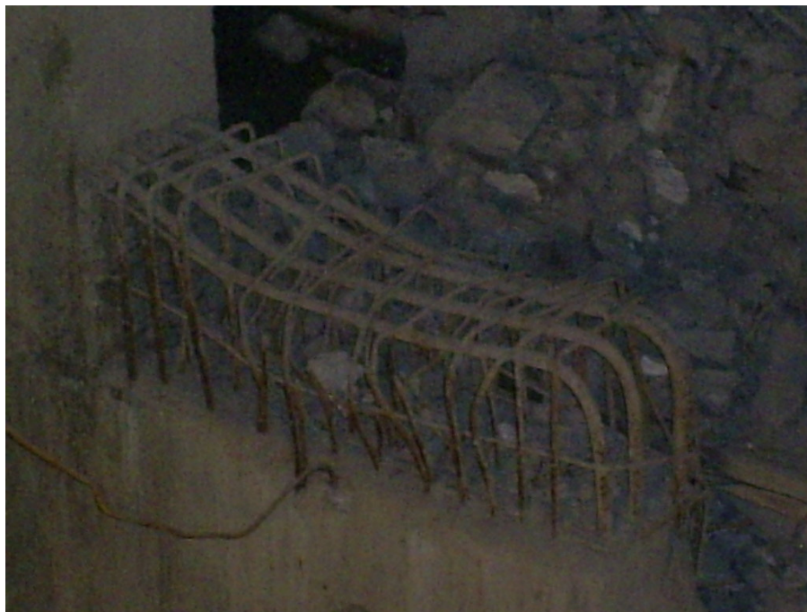
Figura 20. Fotografía de trabajo rehecho. (Demolición de muro)
