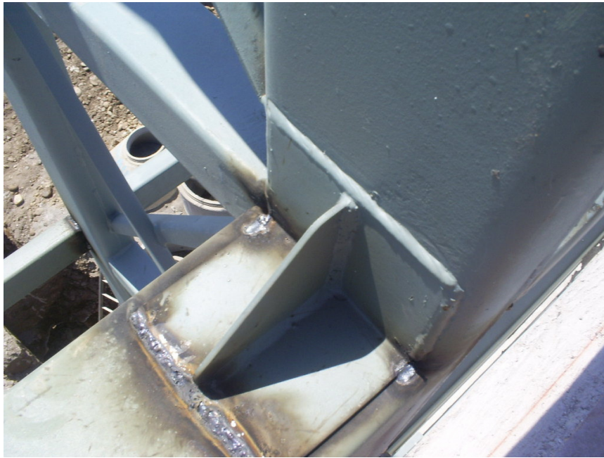
Figura17. Fotografía que muestra el trabajo mal ejecutado. (Falta de filete de soldadura en los costados del perfil L)
