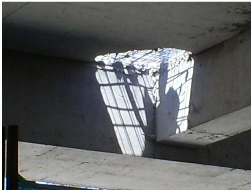
Figura 27. Fotografía una mala planificación. (Pasadas en losas, modificaciones o cambios en la estructura, son un costo considerable una vez que se ha ejecutado la obra gruesa. En general la calidad de estas correcciones, es deficiente y muchas veces mal ejecutada)
