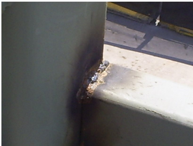
Figura 18. Fotografía que muestra el trabajo mal ejecutado. (Soldadura de mala calidad, exceso de escoria).
