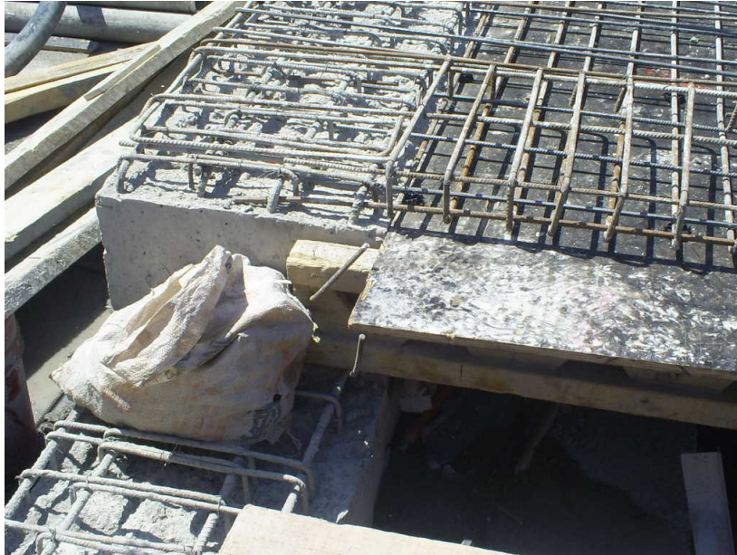
Figura 26. Fotografía de moldaje. (Actividad crítica para controlar)
