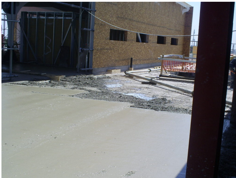
Figura 25. Fotografía del proceso de hormigonado. (Control en terreno)
