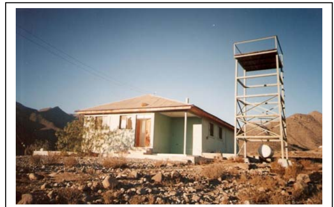
Fig. 8. Edificio abandonado de la planta quesera de Pichasca. Fuente: Elaboración propia.
