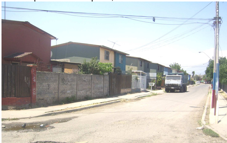
Casas pareadas de 2 pisos, Villa Estaciones Ferroviarias
