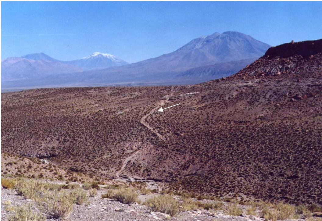
Fig. 14.1 Segmento de Camino de la Vía CAS-90A en sector de quebrada Seca.
