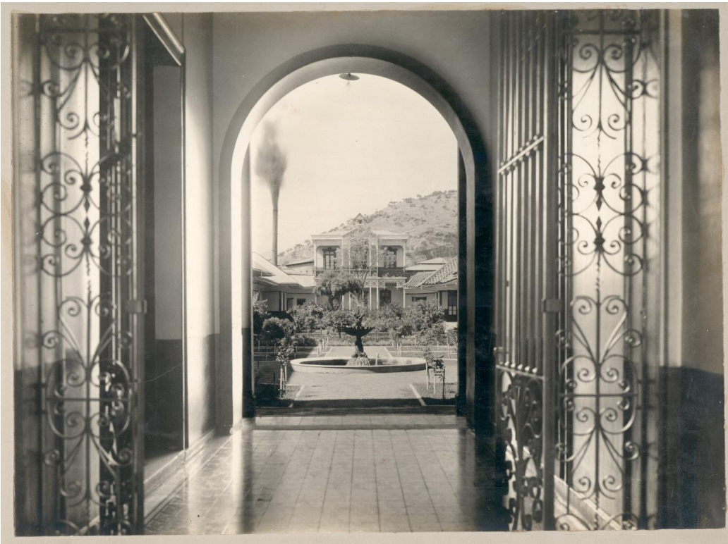
Entrada principal al edificio.
