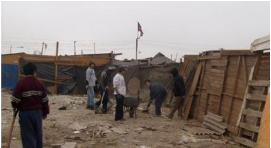
Foto 8: Construcción de nuevo local en campamento
