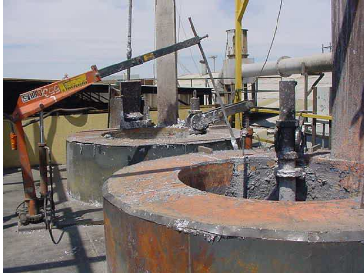
Figura 4.2: Celda de fundición de aleación Pb-Ca-Sn para planchas.
