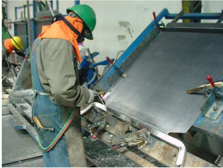
Figura 4.17: Soldadura de un ánodo durante el armado.
