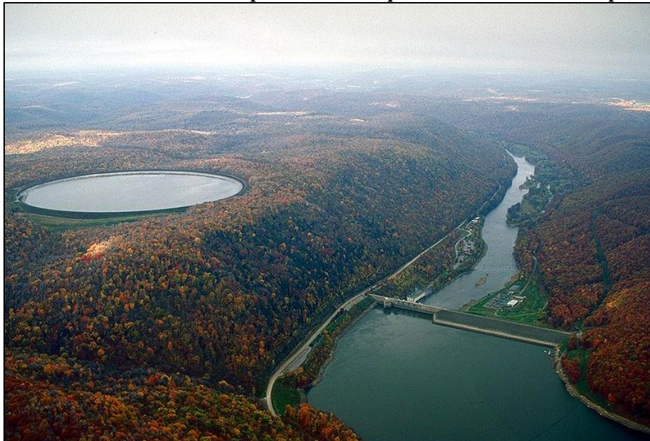
Figura 5: CHAB Seneca. USA. Se observa la piscina artificial que sirve como reservorio superior de la central.
