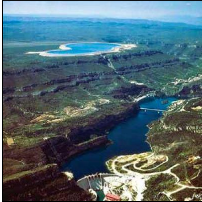
Figura 47: Complejo hidroeléctrico Cortes – La Muela, España.
