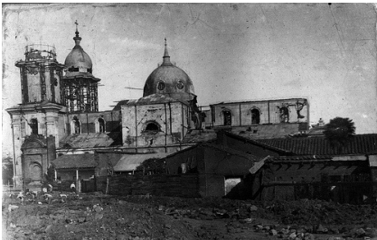
Imagen 22 - 23: Fotografías que muestran los daños causados en la catedral de Talca para el terremoto de 1928.
