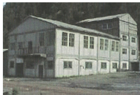
Imagen 71: Muestra el edificio de La Maestranza, éste tenía estructura de hormigón armado y data de 1948. Posee tres niveles y una superficie total de 1.148 mts. 2 .
