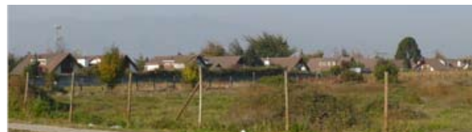
Imagen 17 Viviendas Villa Naturales
