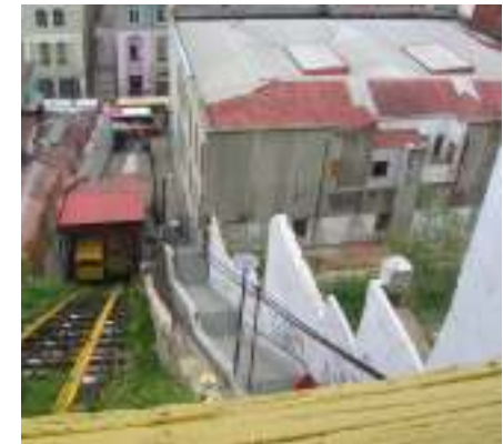
Fachada Posterior desde ascensor.
