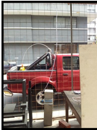
Figura 4. 24: Ensayo de permeabilidad.
