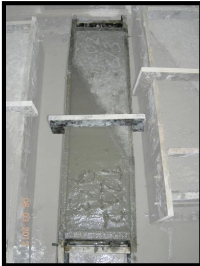
Figura 4. 17: Colocación del hormigón de la segunda etapa.
