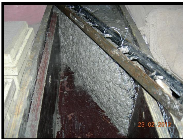
Figura 4. 13: Superficie de contacto al usar la malla metálica galvanizada.
