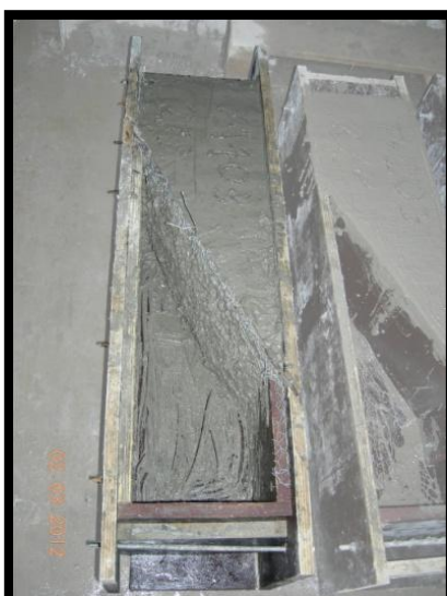
Figura 4. 12: Lechada que pasa a través de la malla metálica.
