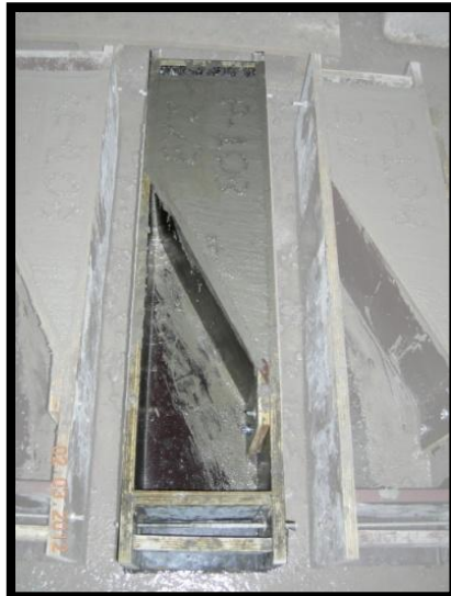
Figura 4. 5: Colocación del hormigón de la primera etapa.
