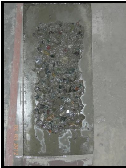
Figura 4. 11: Tratamiento de picado (50% de la superficie).
