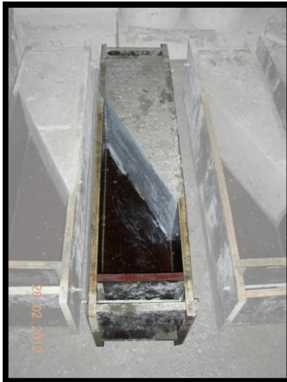
Figura 4. 10: Aplicación del puente de adherencia.
