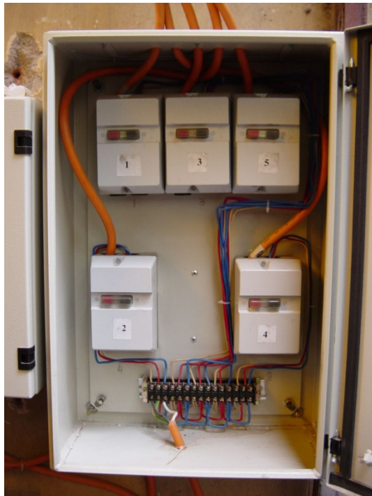
g) Tablero eléctrico de control
