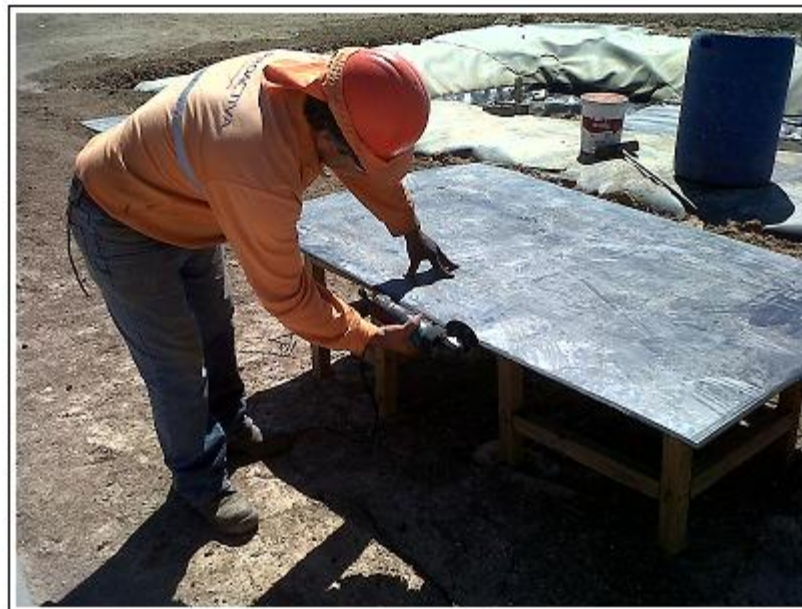
Figura 5.6 Placas de HDPE de 1 [cm] de espesor
