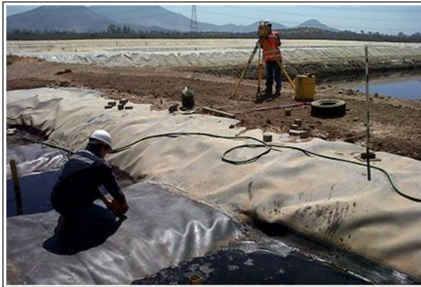
Figura 5.5 Levantamiento topográfico de los pretilos de las bandejas de experimentación
