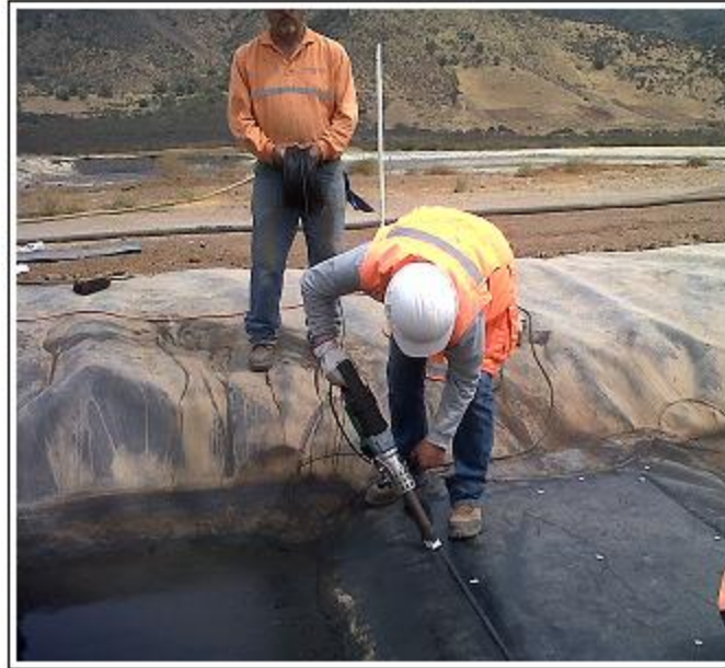
Figura 5.7 Instalación de las placas de HDPE sobre las bandejas de experimentación
