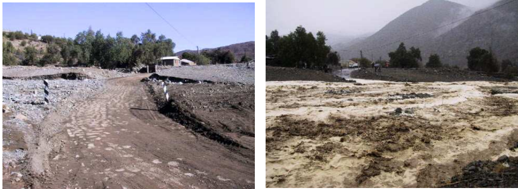
Figura 10. Izquierda: Quebrada de Pichasca. Derecha: Crecida de la Quebrada de Pichasca.
