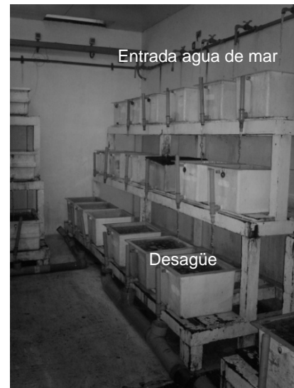
Sistema de agua de mar Fuente: visita centro I-Mar
