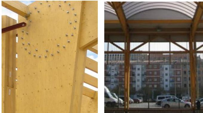
Unión marco rígido pilar y viga madera laminadas y sistema de arriostramiento.
