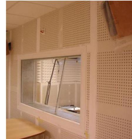
Esquema básico de un resonador múltiple de cavidad (Helmholtz) a base de paneles perforados o ranurados / Utilización de un resonador múltiple de cavidad en un estudio de grabación Fuente: Internet, "Diseño acústico de espacios arquitectónicos", Antoni Carrión.
