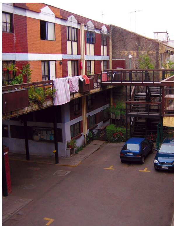
FIG 4. Conjunto de vivienda social Cite 2000, de 1992 producido por la CORDESAN en Santiago Norponiente. Fuente: Arriagada, Moreno y Cartier (2007)
