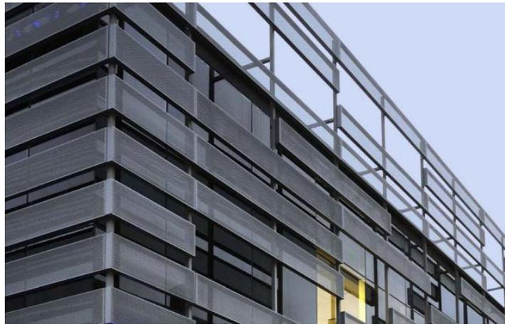
Ilustración 9-6 Protección solar Panel perforado Screenpanel
