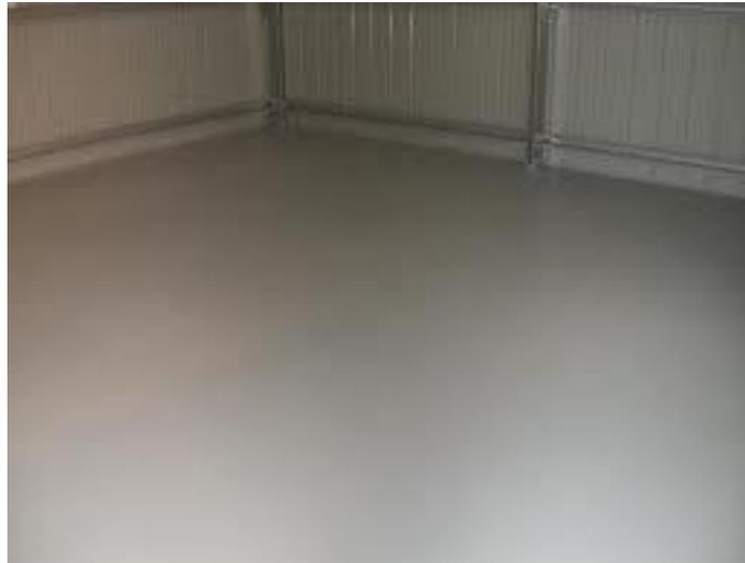
Ilustración 9-8 Revestimiento pisos interiores Sikafloor 20N Pur Cem
